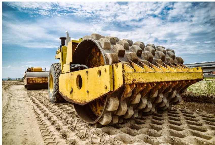
Figura 4 - Compactação com pé-de-carneiro.
