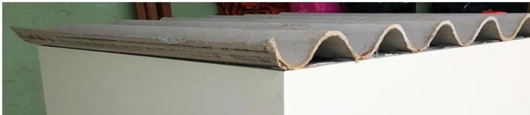
**Figura 29 - Telha fibrocimento**
