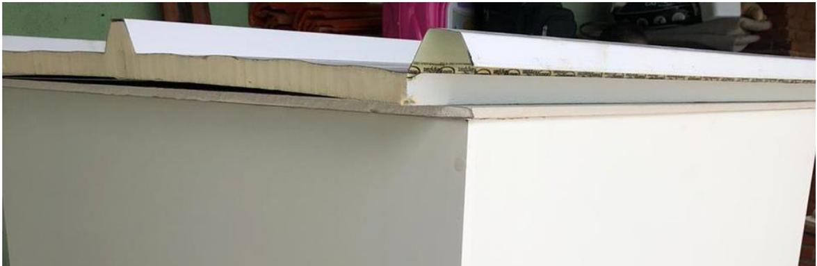
**Figura 23 - Telha termoacústica + forro gesso acartonado**
