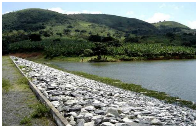
Figura 6 - Talude de Montante protegido por rip rap .
