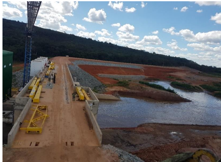
Figura 32 – Construção da Crista.
