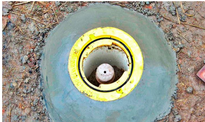
Figura 10 - Execução de Piezômetro Stand Pipe .
