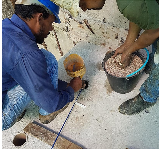
Figura 40 – Instalação do Piezômetro de Corda Vibrante.
