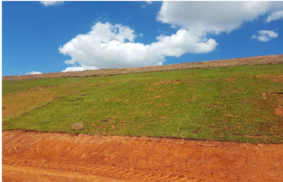
Figura 36 – Sistema Vegetal de Proteção do Talude de Jusante.
