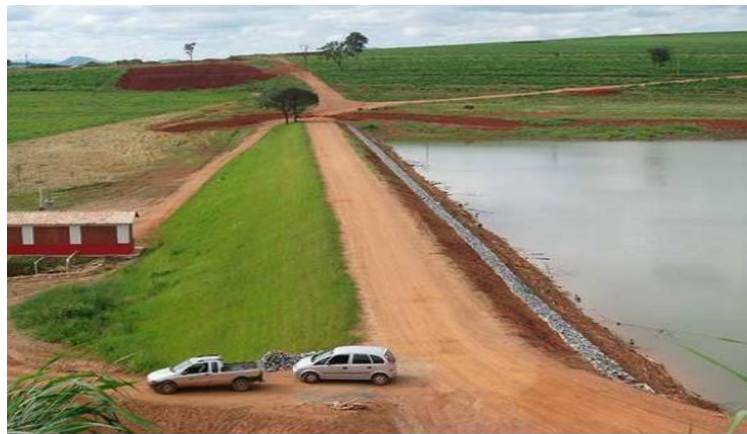
Figura 7 - Proteção com grama do Talude de Jusante.
