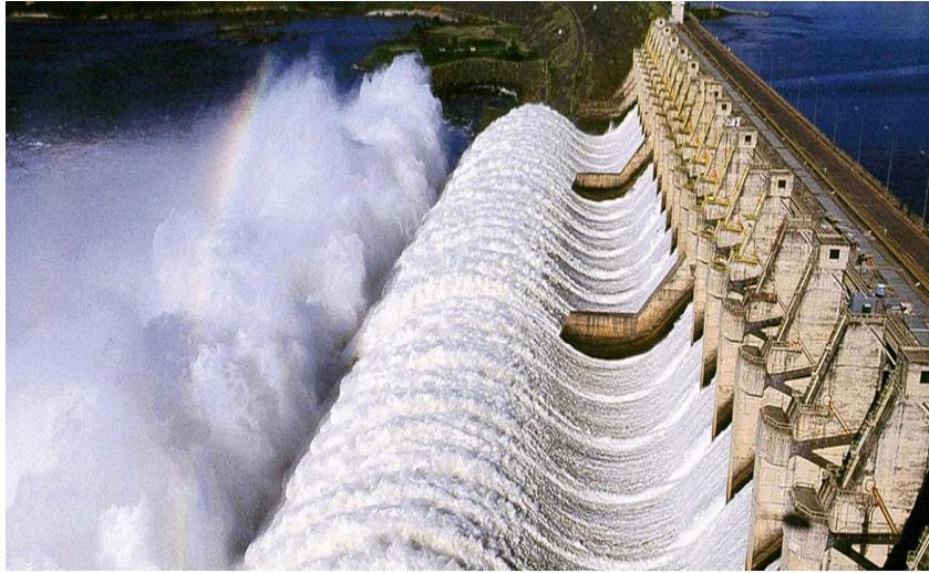
Figura 9 - Vertedouro da Usina Hidrelétrica de Tucuruí.
