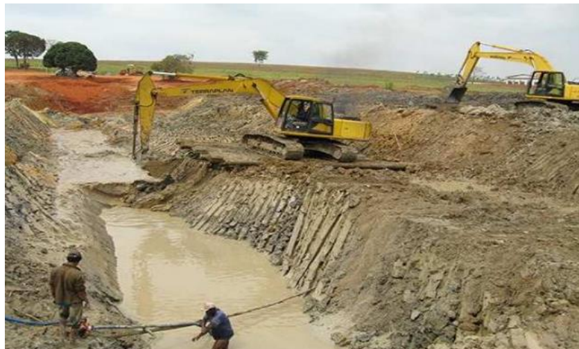
Figura 8 - Abertura do Cut Off .
