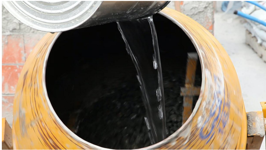
Figura 13 – Aplicação de água no concreto
