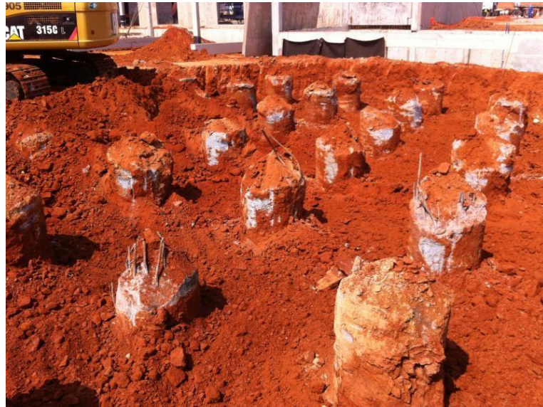
Figura 22 – Estaqueamento de fundações
