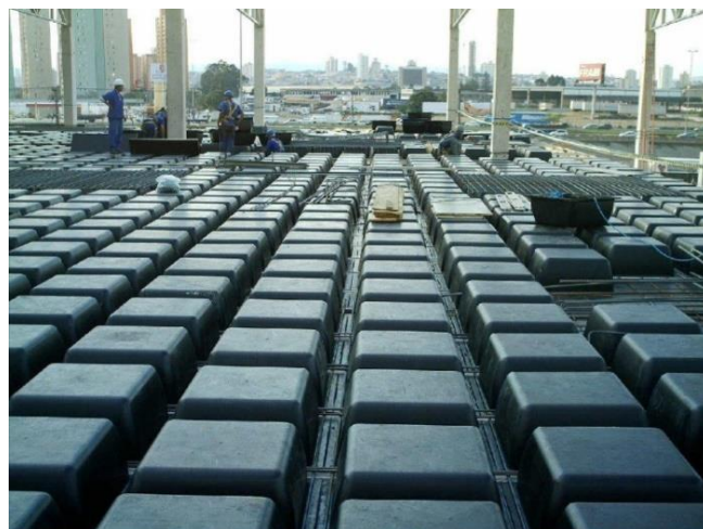
Figura 18 – Laje Nervurada
