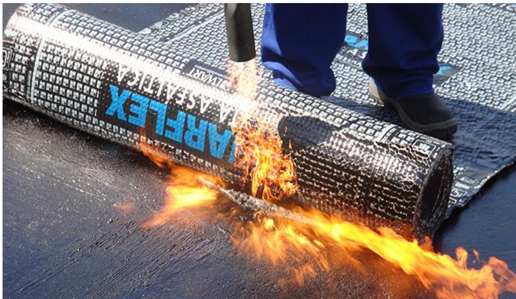
Figura 8 – Aplicação Manta Asfáltica
