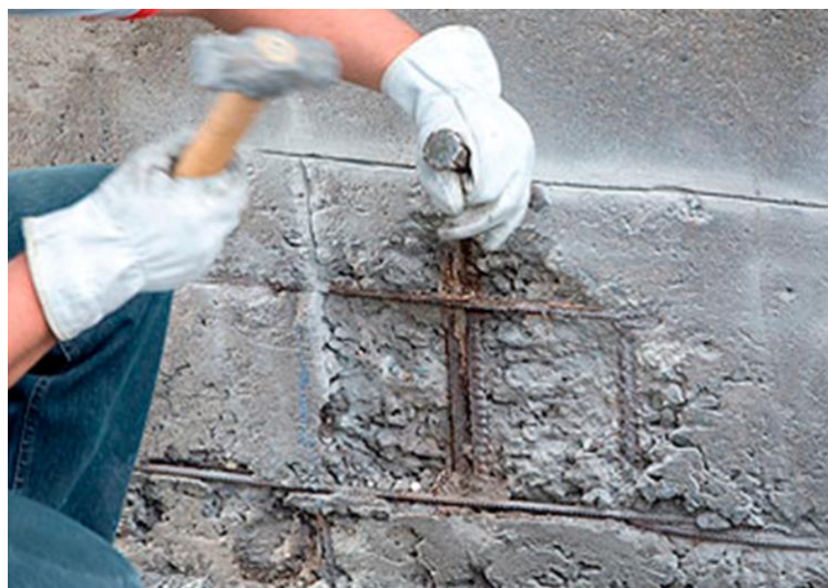
Figura 05 – Corte sendo executado.
