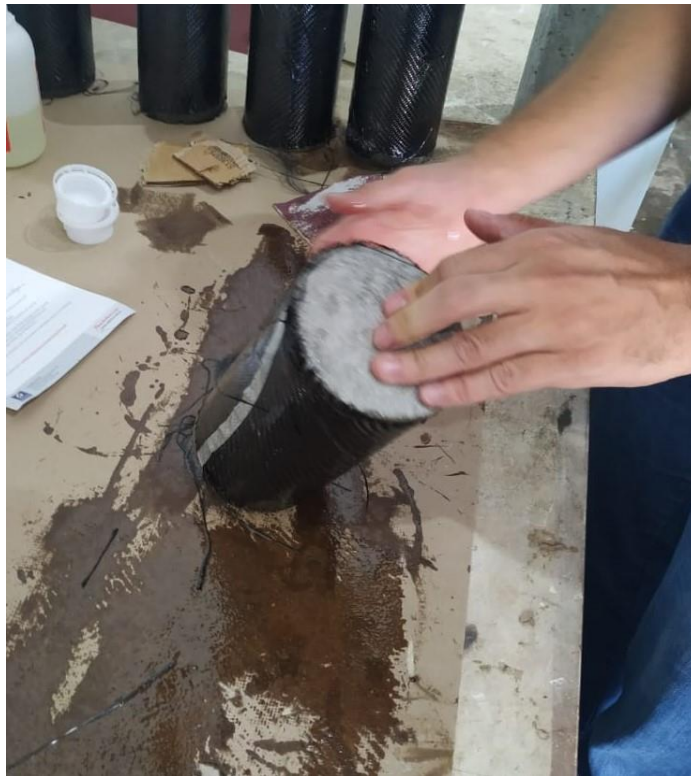
Figura 20 – Aplicação da manta.
