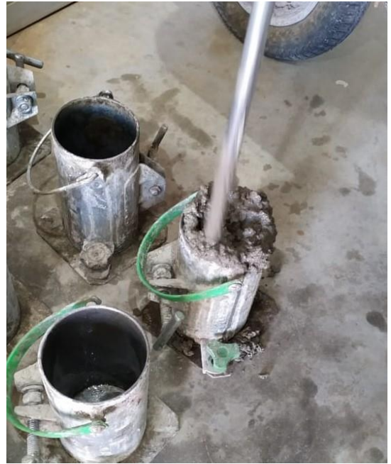
Figura 15 – Adensamento do concreto
