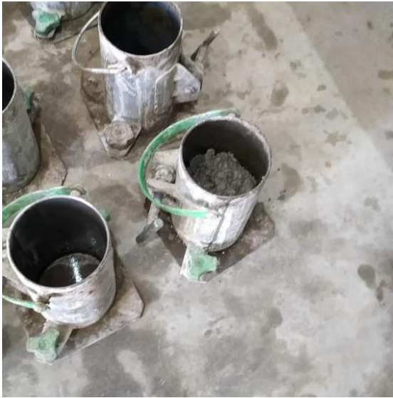
Figura 14 – Colocação do concreto no molde.
