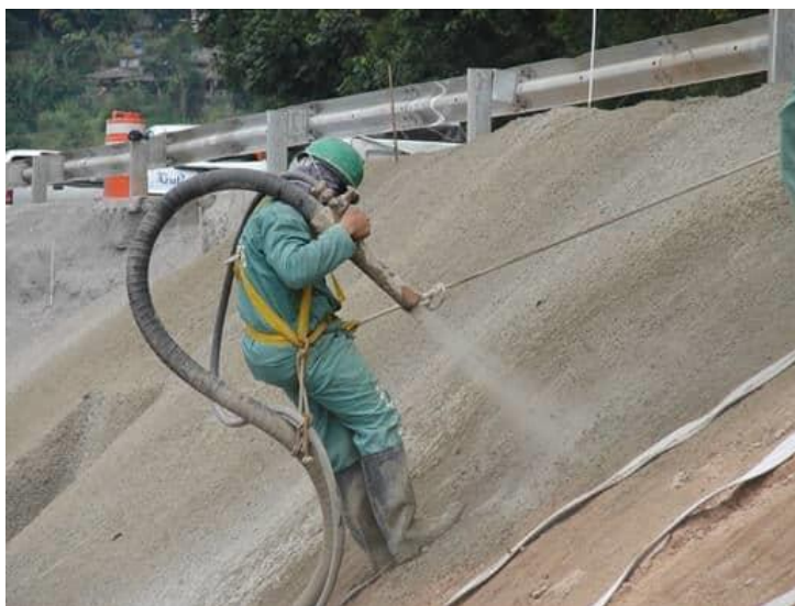
Figura 08 – Execução de concreto projetado com mangote.
