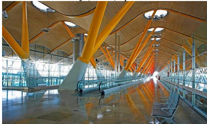
Figura 1 - Forro composto por bambu - Aeroporto Internacional de Barajas, Madrid, Espanha.
