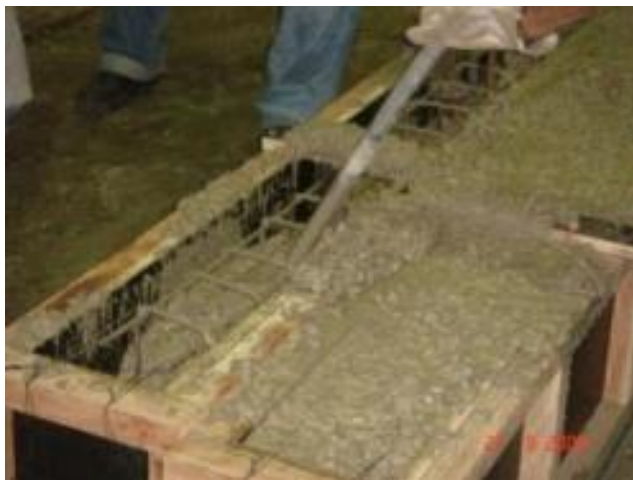
Figura 20- Preenchimento de fôrma com concreto e adensamento interno
