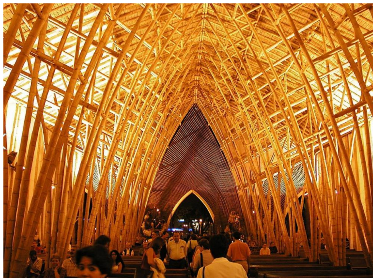
Figura 3 - Uso do bambu na construção da Catedral de Pereira, Colômbia– Símon Velez
