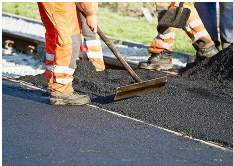
Figura 29: pavimentação a base de agregados reciclados
