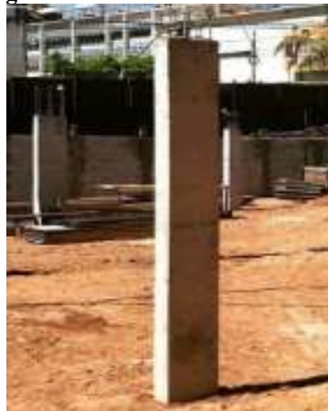
Figura 5 - Pilar de concreto Armado
