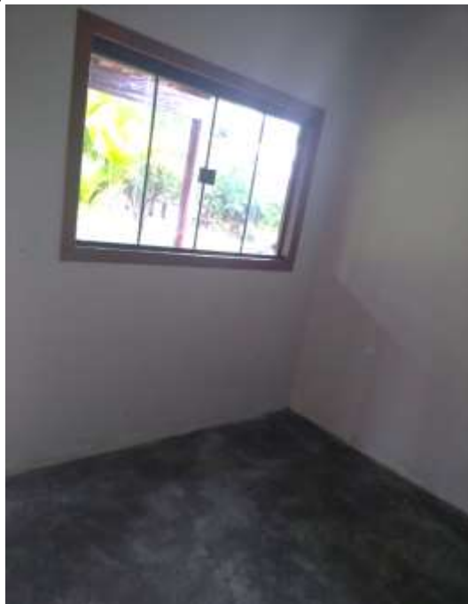
Figura 32 – Pintura acabada no ambiente interno
