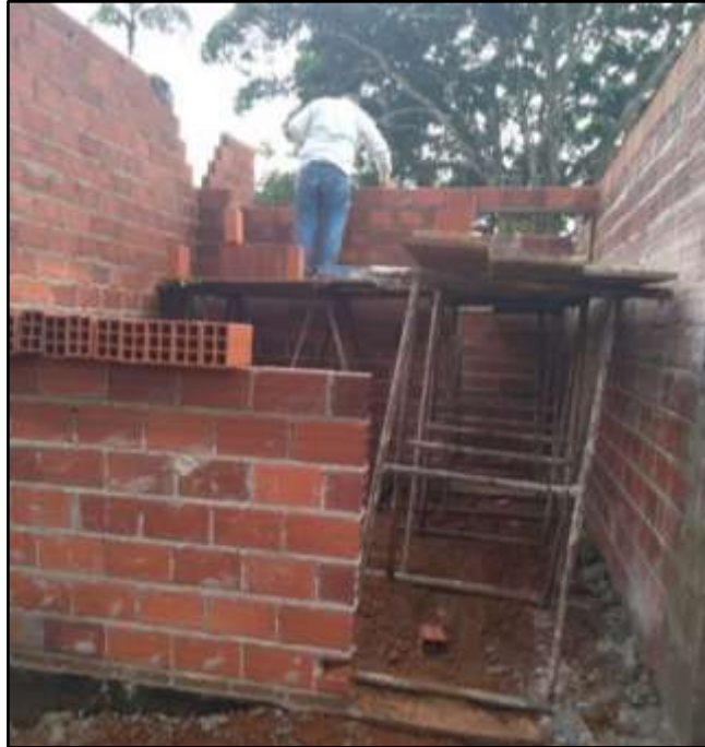
Figura 22 – Levantamento das paredes com blocos cerâmicos
