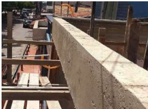
Figura 6 – Viga de concreto.
