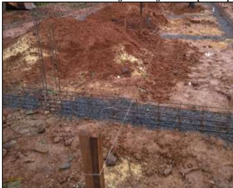
Figura 16 – Posicionamento das ferragens das vigas e arranques dos pilares
