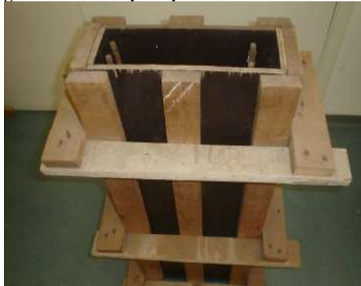
Figura 4 – Fôrma para pilares de concreto armado
