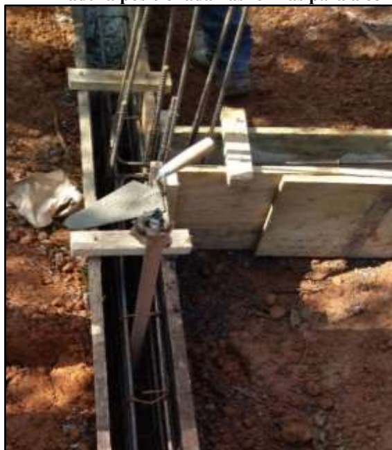
Figura 17– Armadura posicionada nas formas para a concretagem
