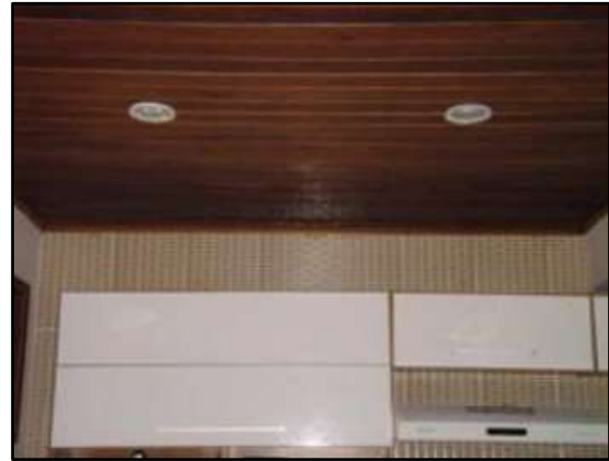
(b) Forro de Madeira
