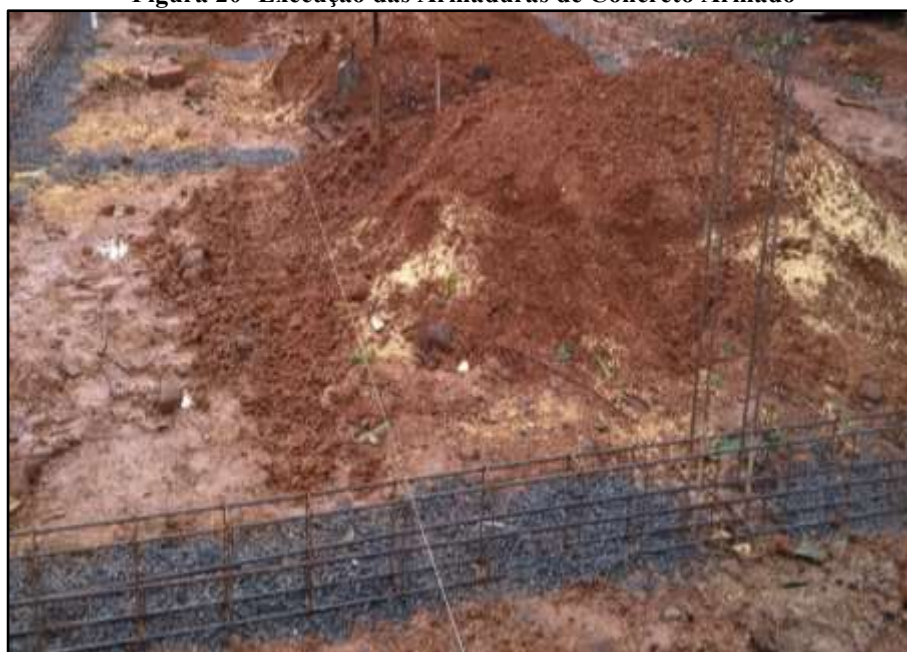
Figura 20- Execução das Armaduras de Concreto Armado
