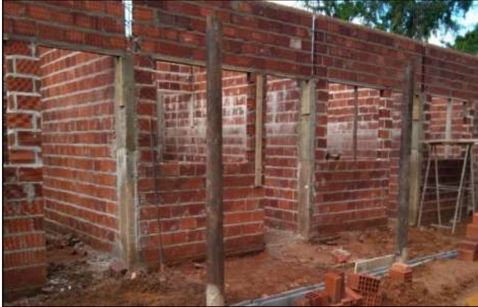
Figura 24 – Execução dos vãos das janelas
