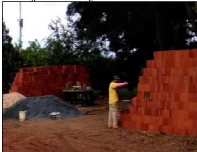
Figura 23 – Estocagem dos blocos cerâmicos
