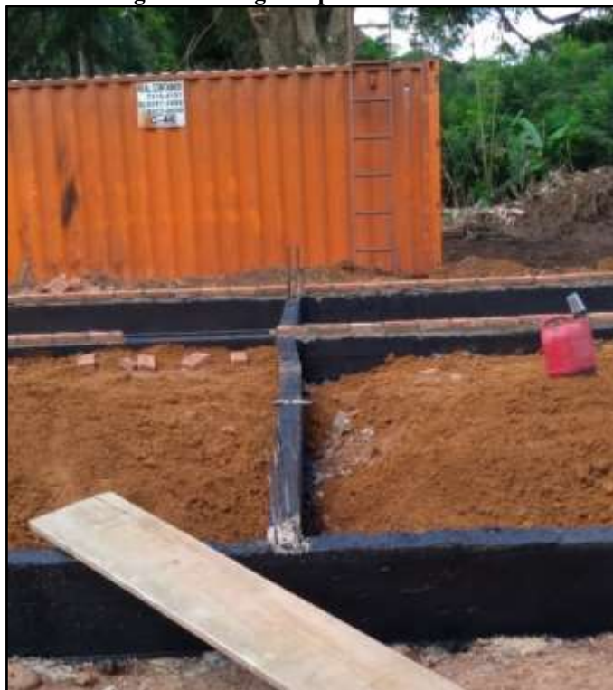
Figura 18– Vigas depois de concretadas
