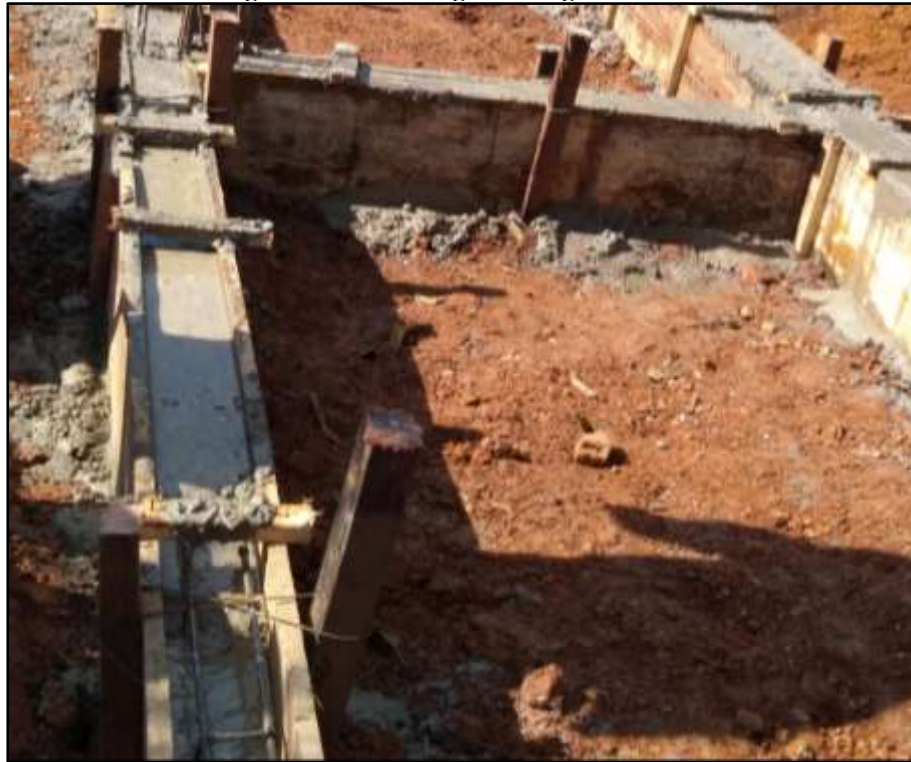
Figura 21- Concretagem da viga baldrame
