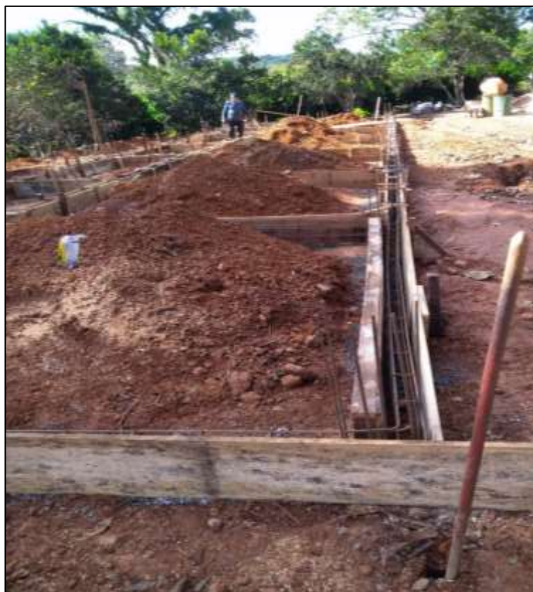
Figura 19- Execução de Formas da fundação
