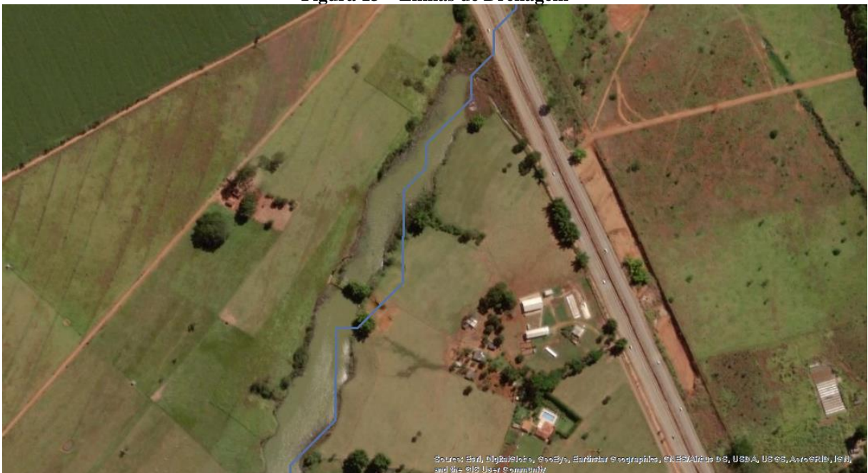
Figura 13 – Linhas de Drenagem
