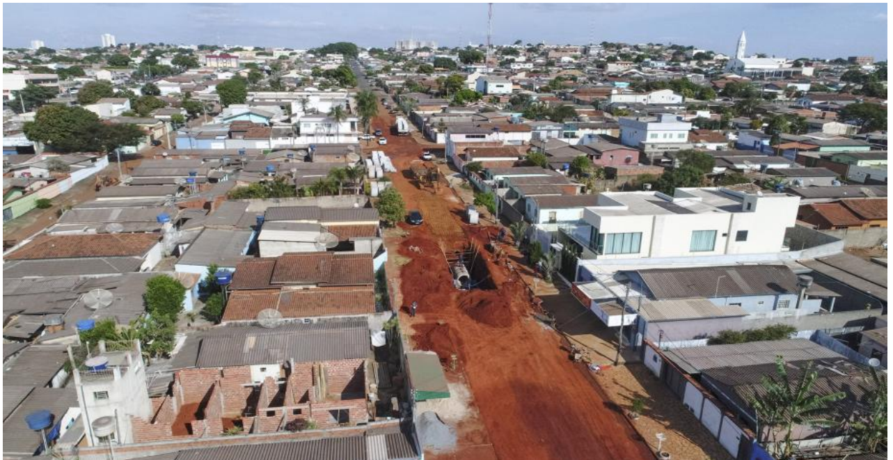
Figura 4 - Obra adequação do sistema de drenagem na rua Formosa
