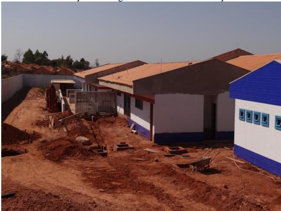
Ilustração 9 –Imagens da creche em construção
