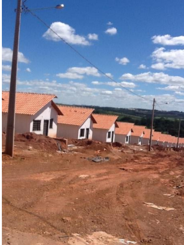
Ilustração 25 – Casas edificadas sem pavimentação asfáltica
