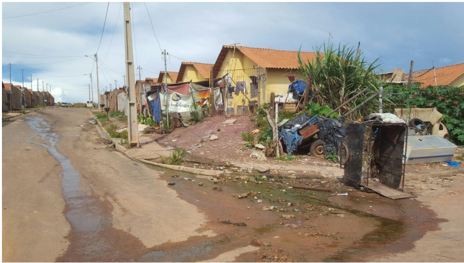
Ilustração 41: Ausência de higiene sanitária e rede de esgoto.
