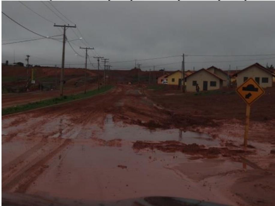
Ilustração 36 – Situação da avenida principal, tomada por lama após as primeiras chuvas
