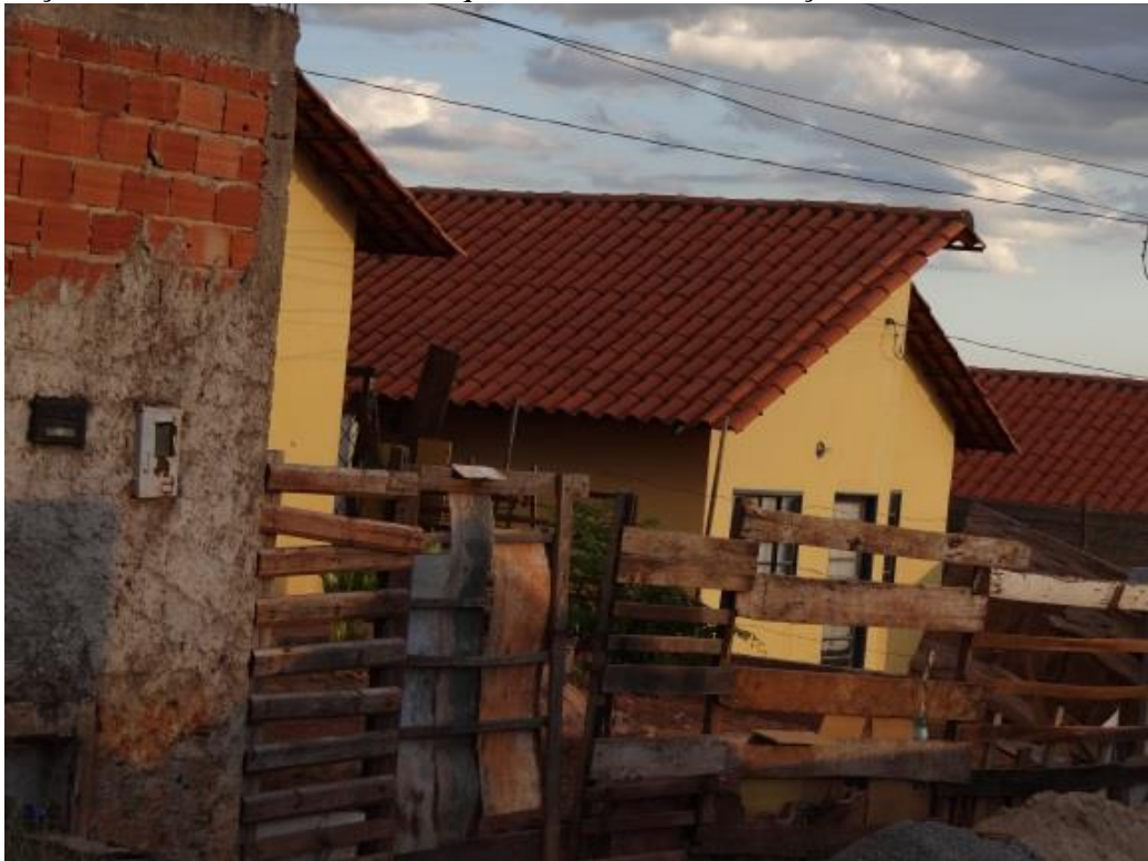
Ilustração 24 – Estrutura das casas, que demonstram a condição de miséria de moradores
