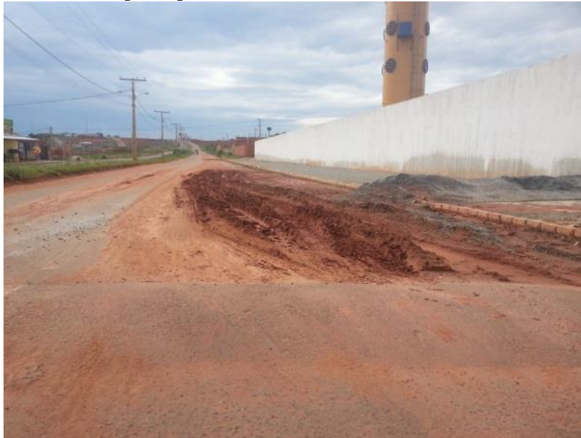
Ilustrações 10 –Avenida principal e terreno ao lado da creche, ambos tomados por terra
