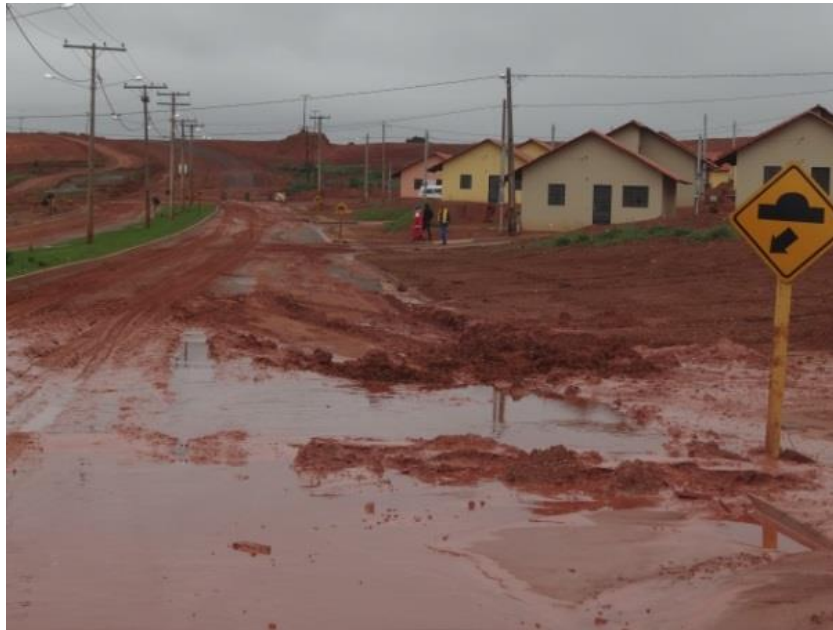
Ilustração 37 – Situação da avenida principal, tomada por lama após as primeiras chuvas
