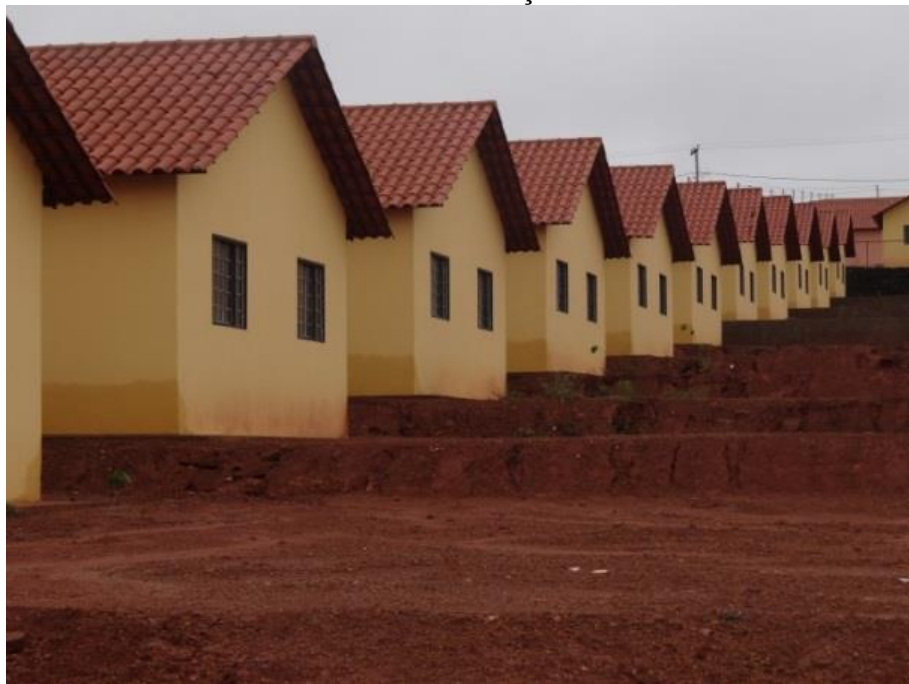
Ilustração 28 – Casas ainda não inauguradas, mas que apresentavam problemas estruturais, como infiltração
