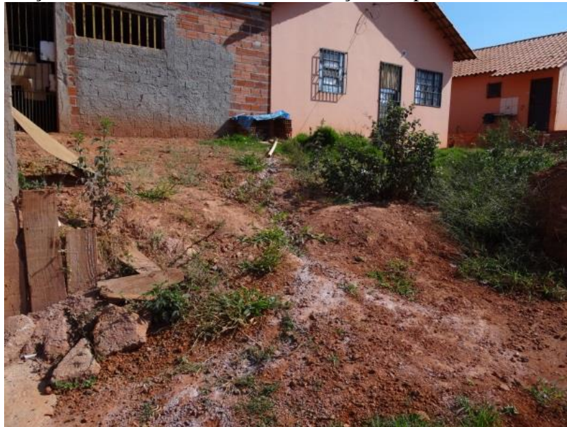
Ilustração 4 – Frente de uma casa sem calçada e apresentando desnível
