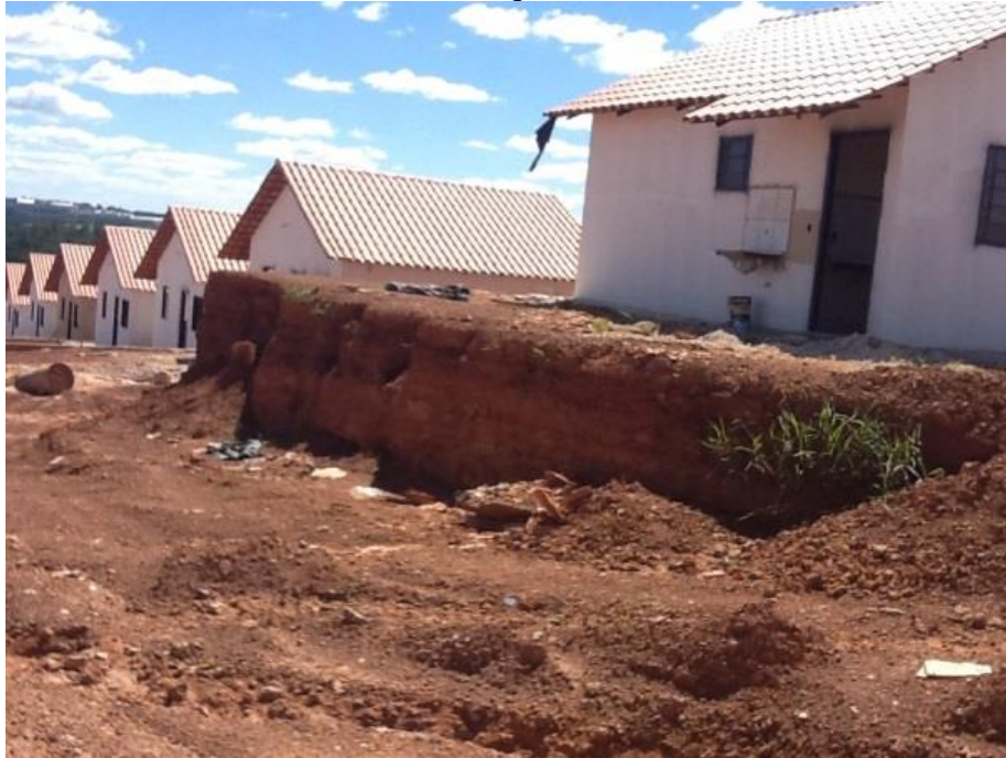
Ilustração 27 – Casas construídas em áreas que não foram aterradas, mostra do desnível
