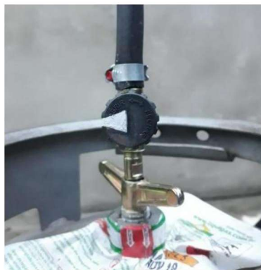
Imagem 4 – \frac{1}{4} de volta, registro botijão de gás.
