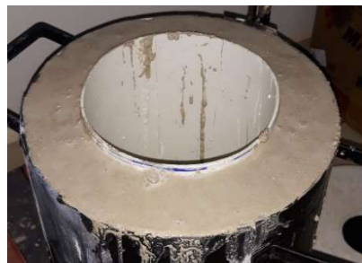
Figura 12 - Acabamento da parede de concreto refratário
