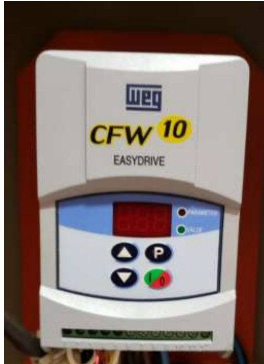
Figura 3.9 - Inversor de frequência
