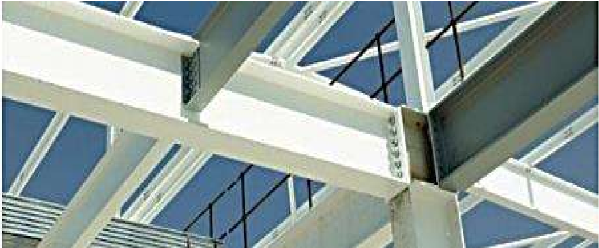
Figura 2.3 - Vigas em Perfil Metálico.
