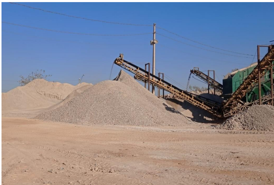
Figura 3 - Usina de reciclagem de resíduos da construção civil (Aparecida de Goiânia-GO).
