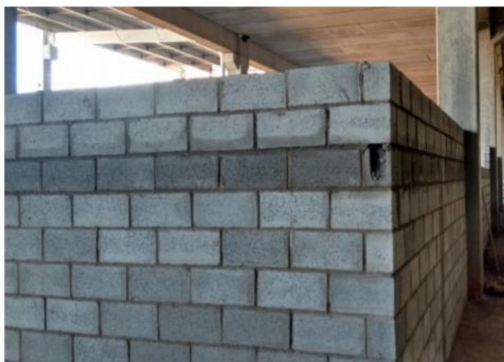
Figura 4 – Edificação utilizando alvenaria de vedação racionalizada.
