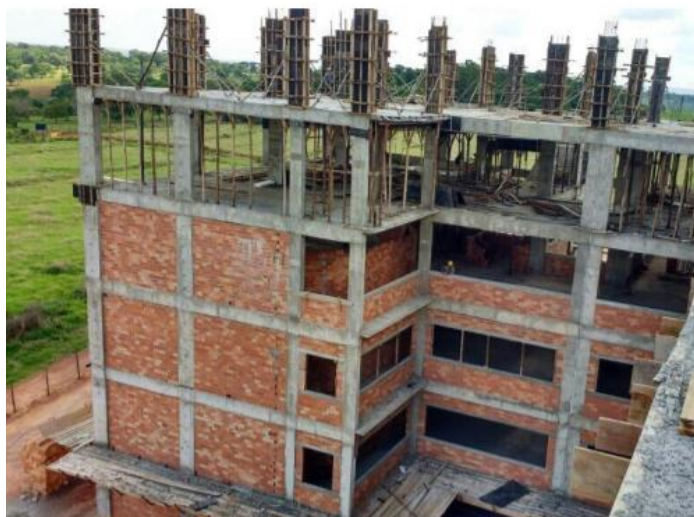
Figura 2 – Edificação utilizando alvenaria de vedação em blocos cerâmicos.
