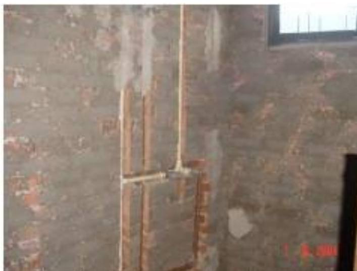
Figura 3 – Edificação utilizando alvenaria de vedação em blocos cerâmicos.
