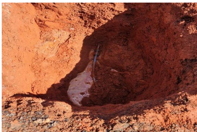
Figura 12 – Ramal com o vazamento ainda ocorrendo.
