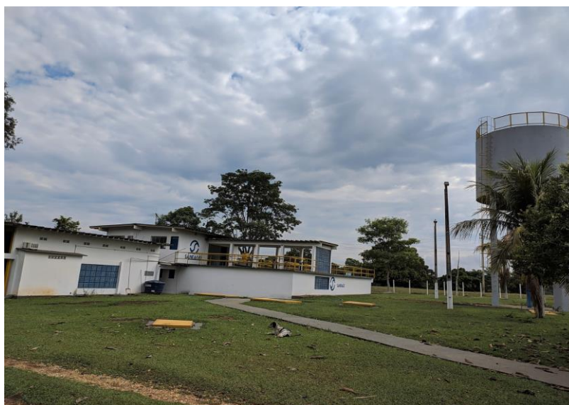
Figura 4 - Estação de tratamento de água do município de Jaraguá.
