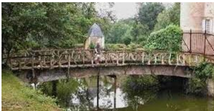
Figura 1 - Primeira ponte de concreto armado.
