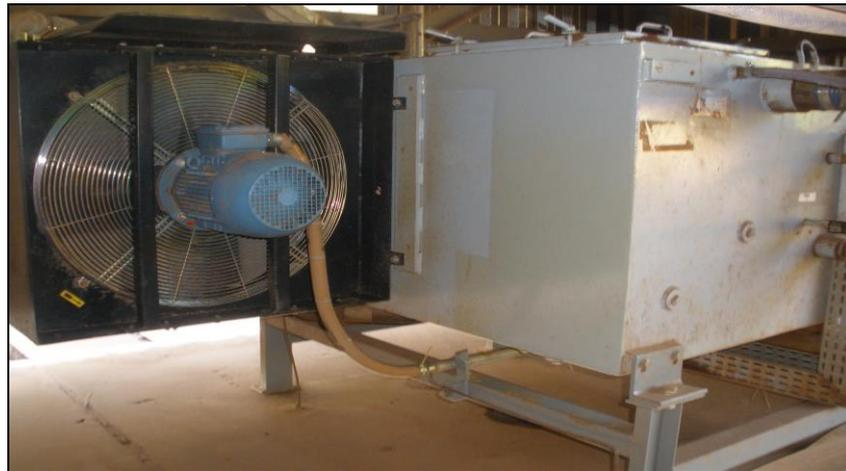
**Figura 10 - Unidade Hidráulica do Britador**
