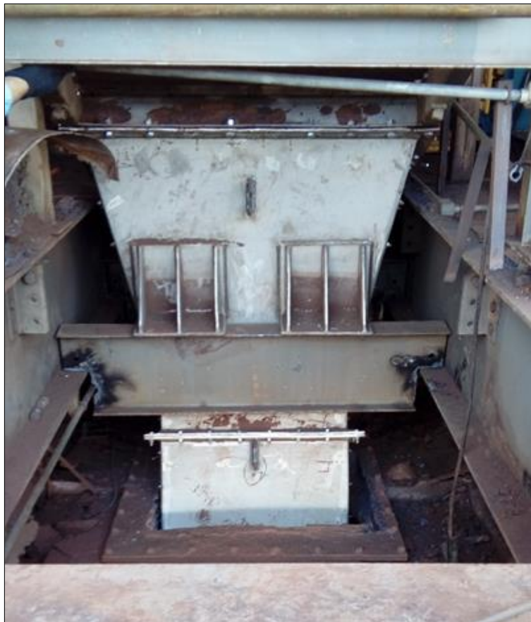
Figura 20 – Montagem do novo chute em 2018 Fonte: O autor (2021).
