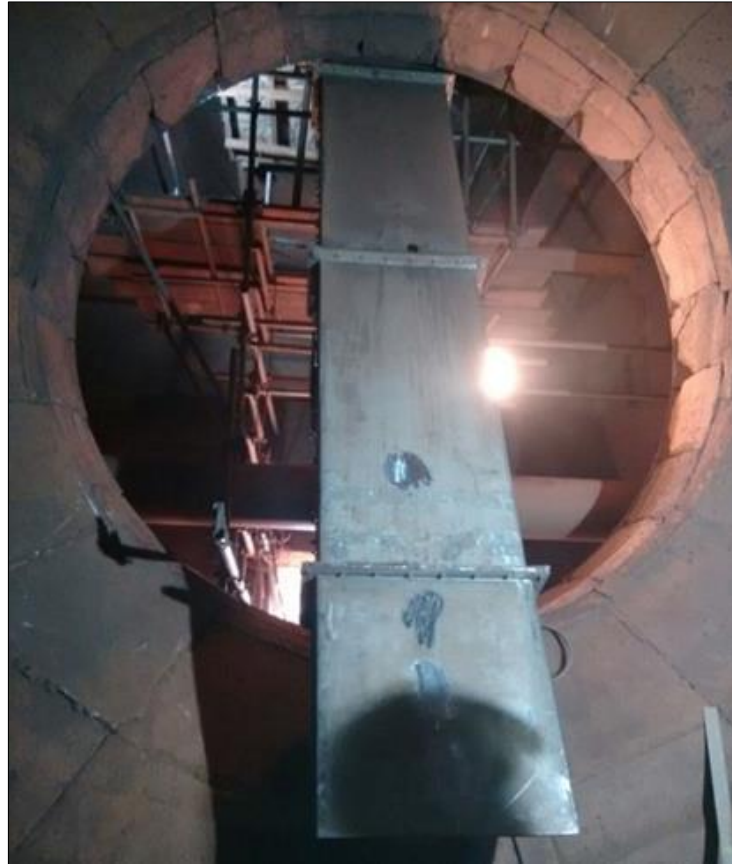
Figura 21 – Montagem do tubo de alimentação - Concluída Fonte: O autor (2021).
