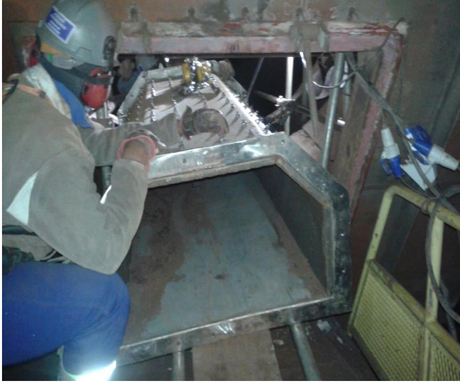
Figura 19 – Montagem em campo em 2018 Fonte: O autor (2021).
