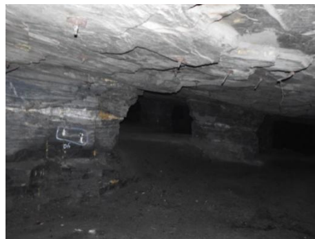
Figura 9 – Pilar com monitoramento crack meter
