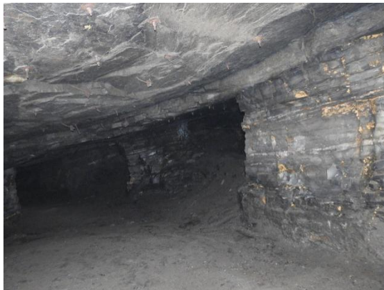
Figura 7 – Pilares após realização de lavra, método câmara de pilares
