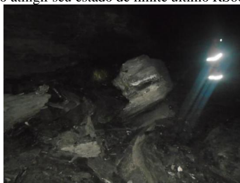
Figura 12 – Pilar ao atingir seu estado de limite ultimo RS602, out 2019
