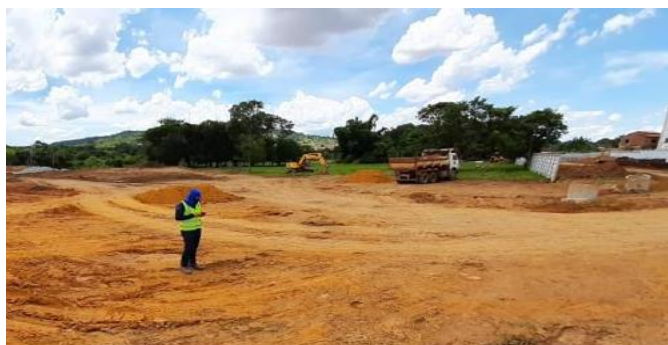
Figura 6 – Equipe especializada para iniciar a fundação da obra.
