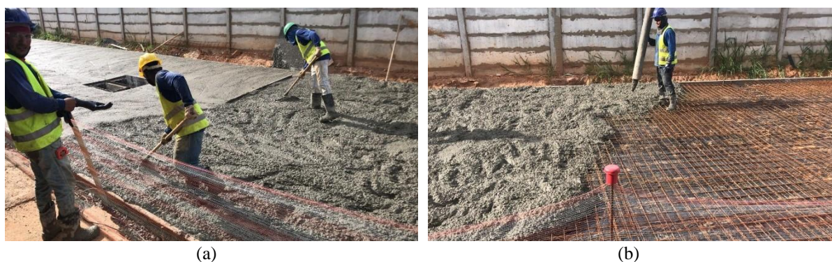
Figura 7 – Trabalhadores fazendo a concretagem (a) e (b).
