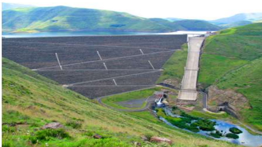
Figura 06: Barragem de Enrocamento
