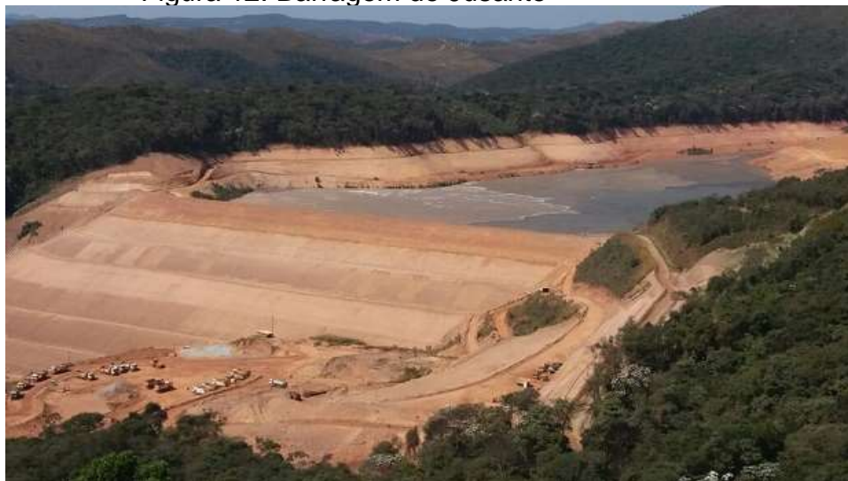
Figura 12: Barragem de Jusante
