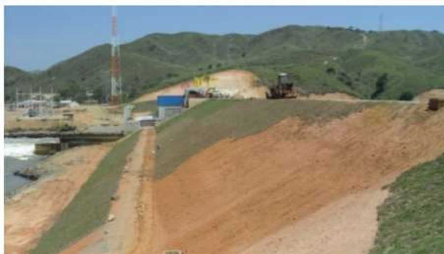
Figura 05: Barragem de Terra
