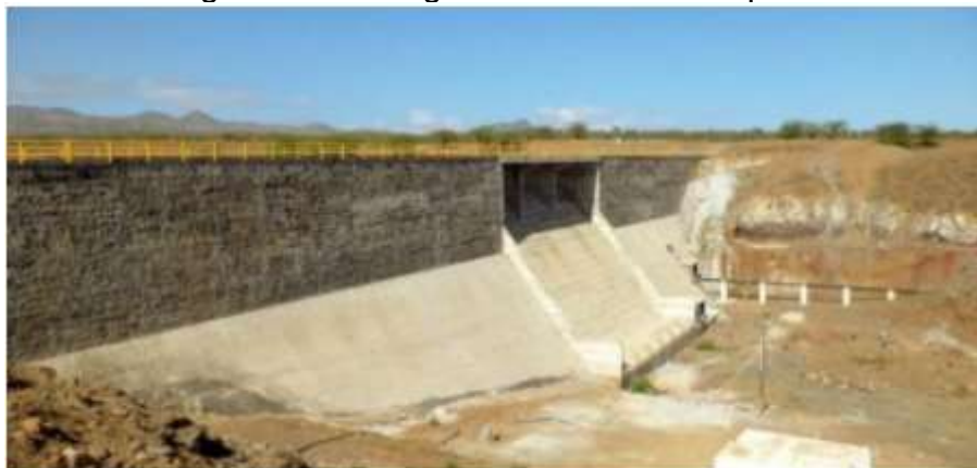
Figura 11: Barragem de alvenaria de pedra
