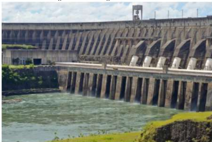
Figura 07: Barragem de Concreto
