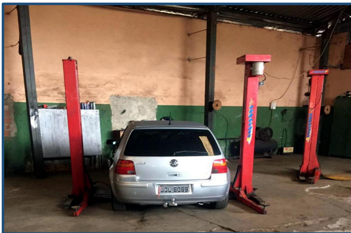
Figura 1 – Elevadores de veículo instalados na empresa
