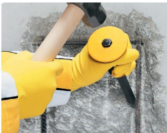
Figura 13 – Eliminando área desgastadas
