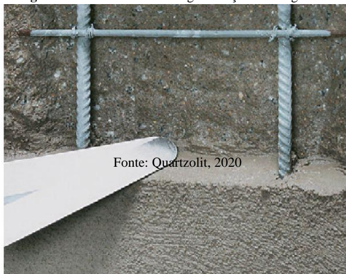
Figura 17 – Adensamento e regularização com argamassa
