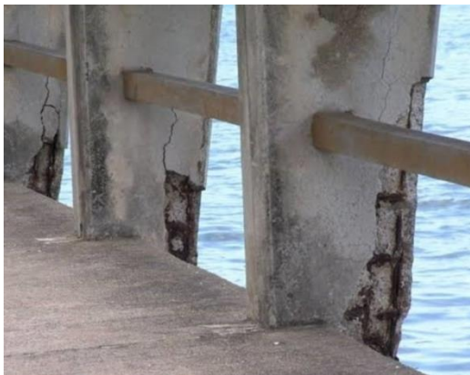
Figura 3 - Corrosão de armaduras.
