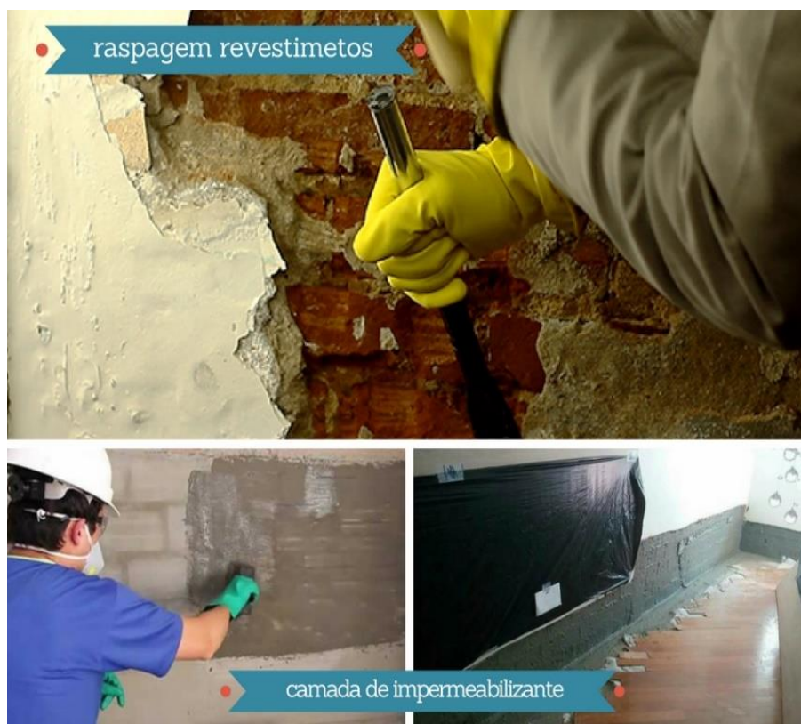
Figura 10 – Corrigindo infiltrações em viga baldrame
