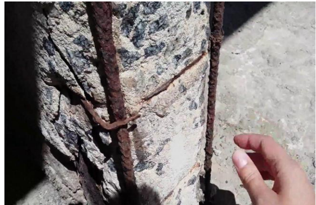
Figura 3 - Corrosão de armaduras.
