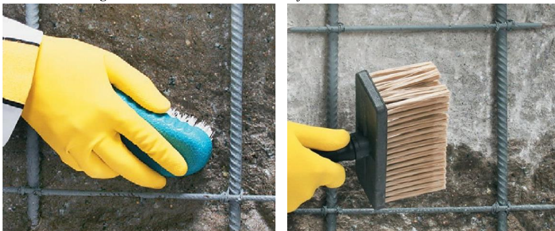
Figura 16 – Retirada de excesso de sujeira e molhando área à restaurar
