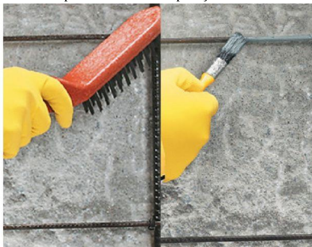
Figura 15 – Limpeza de armadura e aplicação de inibidor de corrosão
