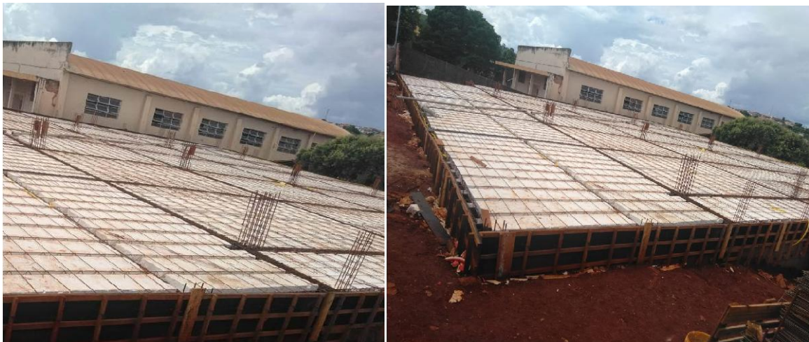
Foto 5 e 6: Fonte própria dos acadêmicos, laje preparada para receber a concretagem.
