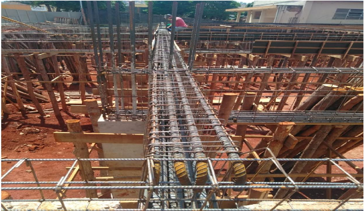
Foto 4: Fonte própria dos acadêmicos, amarração de ferragens.
