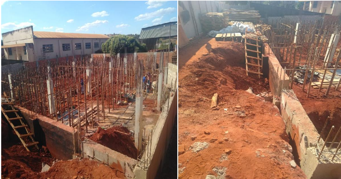
Foto 1 e 2: Fonte própria dos acadêmicos obra em etapa colocação de escoras para receber as formas da laje.
