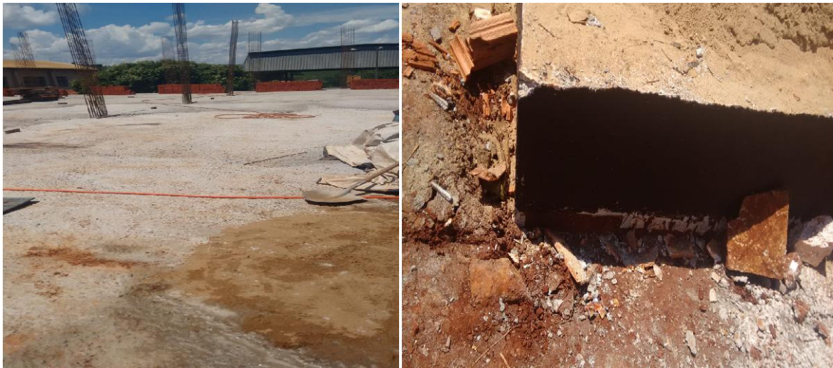
Foto 7 e 8: Fonte própria dos acadêmicos, laje concretada e impermeabilizada.
