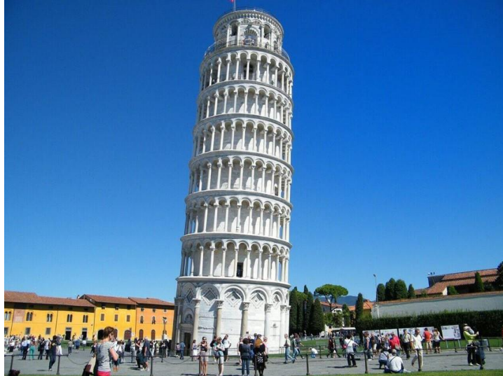
Figura 2. Recalque de apoio.
