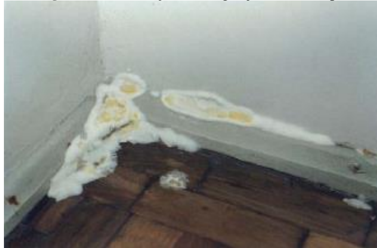
Figura 8. Proliferação de fungos junto ao rodapé.
