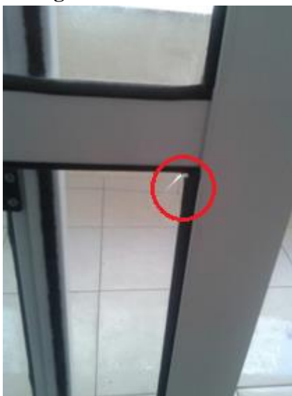
Figura 1. Vidro trincado.
