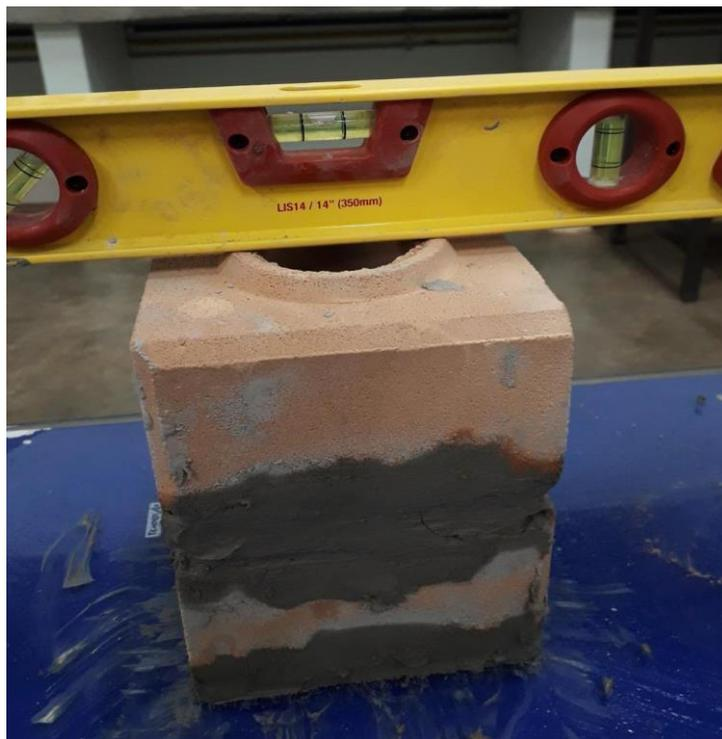
**Figura 3.2.** Verificação do nível dos blocos (Próprio Autor, 2019)
