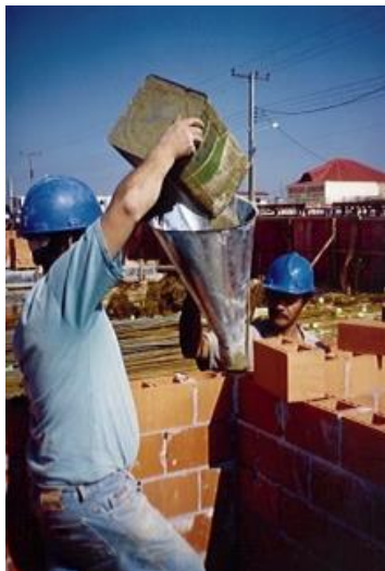
Figura 23 – Grauteamento em zona de concentração de tensões.
