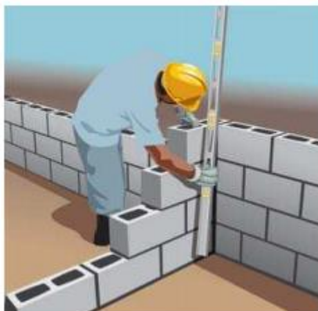
Figura 14 – Assentamento de bloco.
