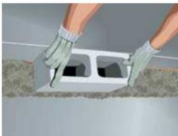
Figura 12 – Assentamento de bloco.
