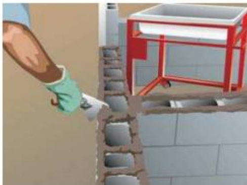
Figura 16 – Assentamento de bloco
