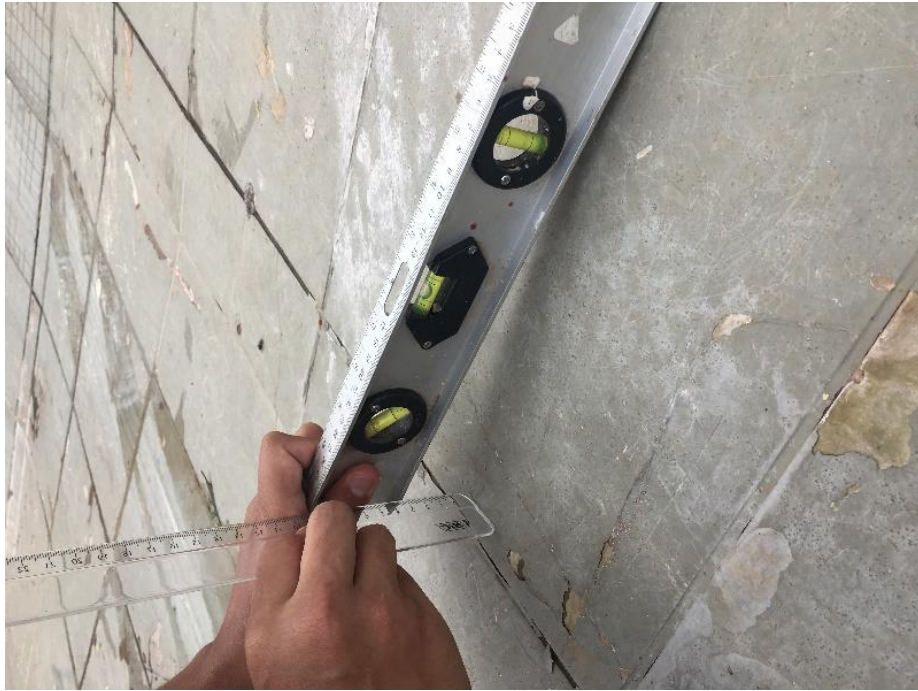
Figura 27 - Exemplo da medição de inclinação de rampa
