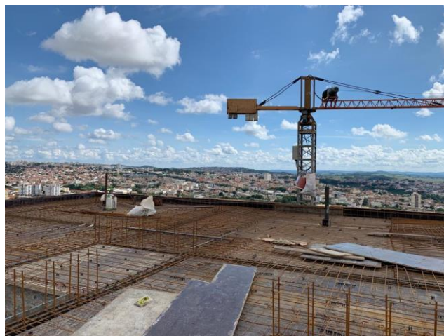
Figura 13 - Minigrua para transportede materiais
