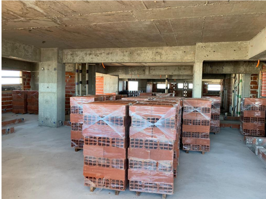
Figura 24 – Abastecimento de Tijolos para Alvenaria
