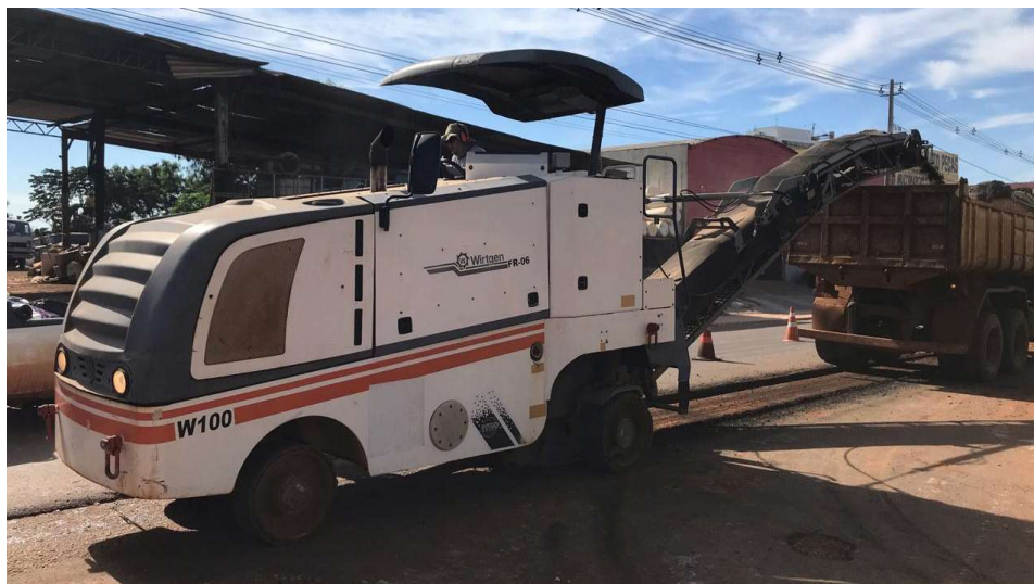
Figura 8 - Fresagem de pavimento
