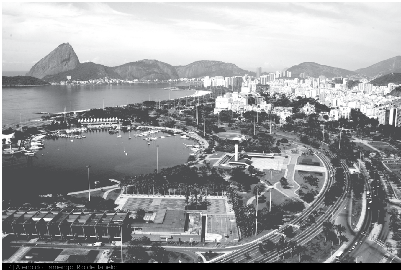
[f.4] Aterro do Flamengo, Rio de Janeiro
