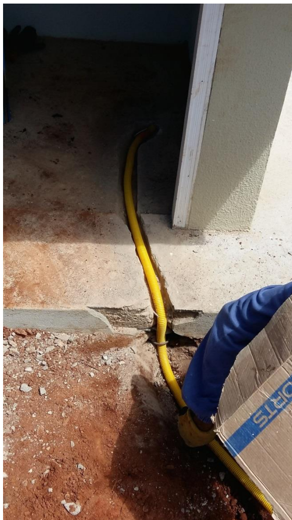
Figura A. 6. Instalação de eletrodutos subterrâneo (Fonte: acervo pessoal).
