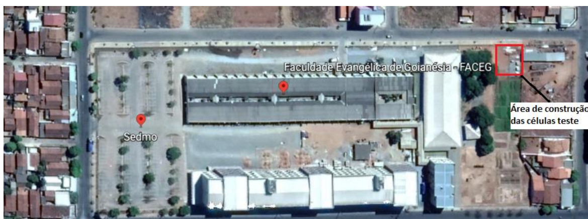
Figura 7. Vista superior da área de construção das células teste (Fonte: Google earth, 2018).
