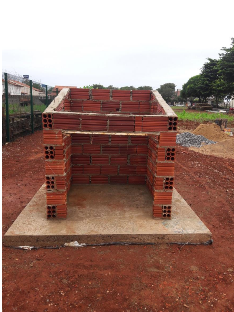
Figura A. 3. Levantamento da alvenaria com blocos cerâmicos de 19 x 14 x 9 cm (Fonte: acervo pessoal).
