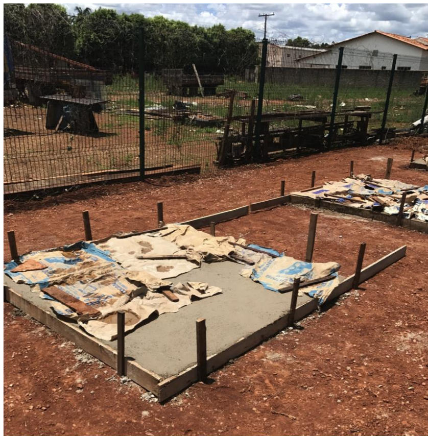
Figura A.2. Cura do concreto com auxílio de sacos de cimento molhados garantindo que a água seja abundante para a total reação do cimento (Fonte: acervo pessoal).
