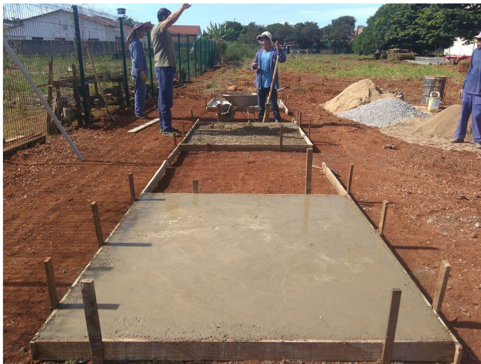
Figura A. 1 Construção dos radiers (Fonte: acervo pessoal).
