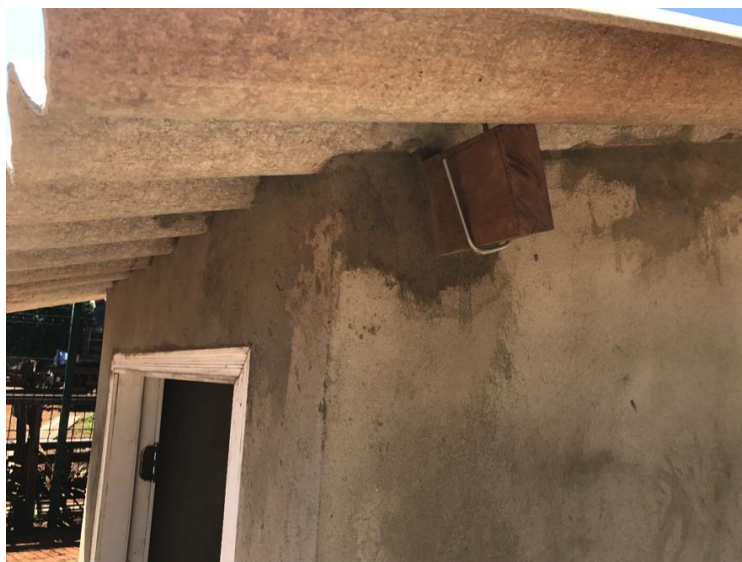
Figura A. 5. Montagem da telha de fibrocimento fixada aos caibros com parafusos sextavados de 10 cm. (Fonte: acervo pessoal).
