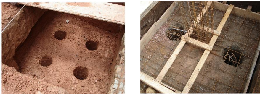
Figura 3.4 - Fundação profunda já escavada do tipo broca
