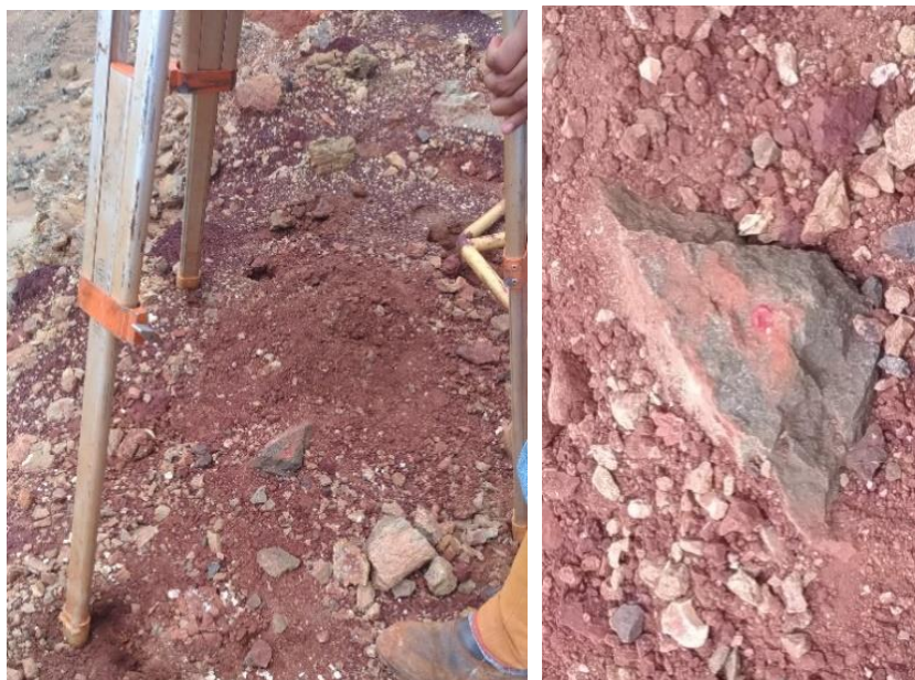
Figura 16: Marcação feita para instalar o LASER scanner na posição determinada. Fonte: Arquivo pessoal.
