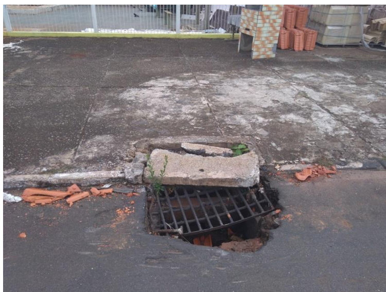
Figura - 17 - Boca de Lobo N.º 16.
