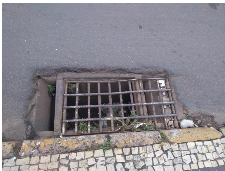
Figura - 5 - Boca de Lobo N.º 4.
