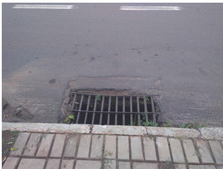
Figura - 15 - Boca de Lobo N.º 14.
