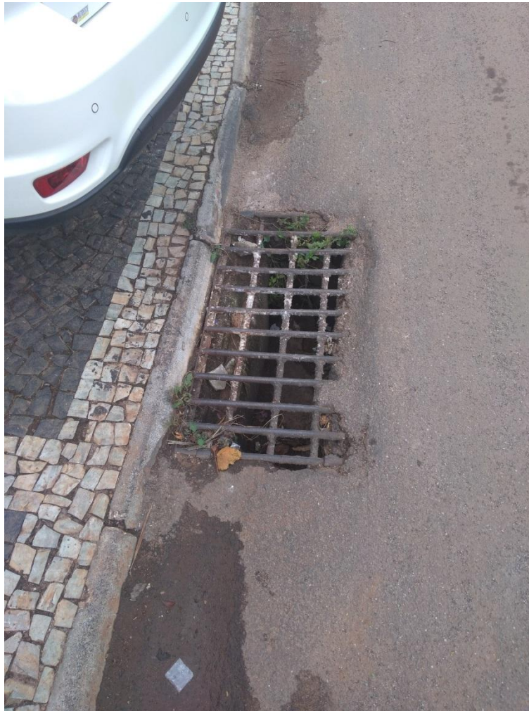
Figura - 19 - Boca de Lobo N.º 18.
