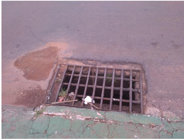
Figura - 13 - Boca de Lobo N.º 12.
