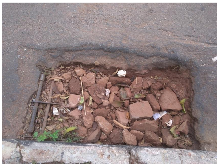
Figura - 23 - Boca de Lobo N.º 22.
