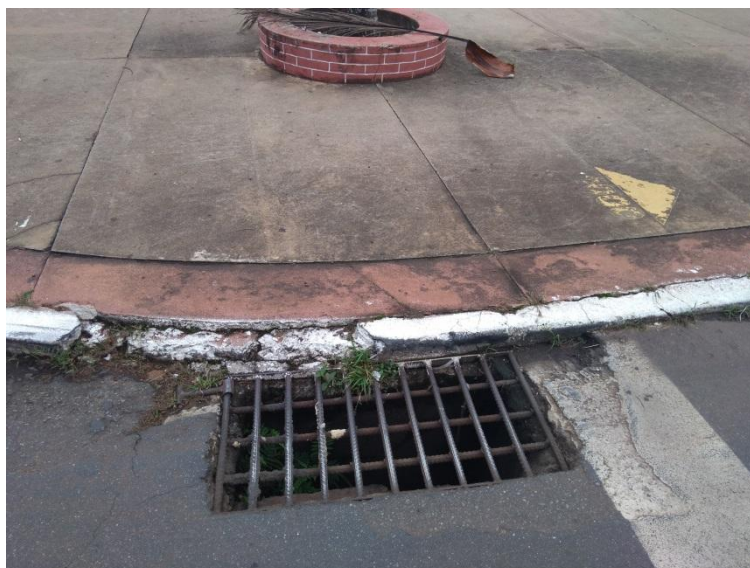
Figura - 6 - Boca de Lobo N.º 5.
