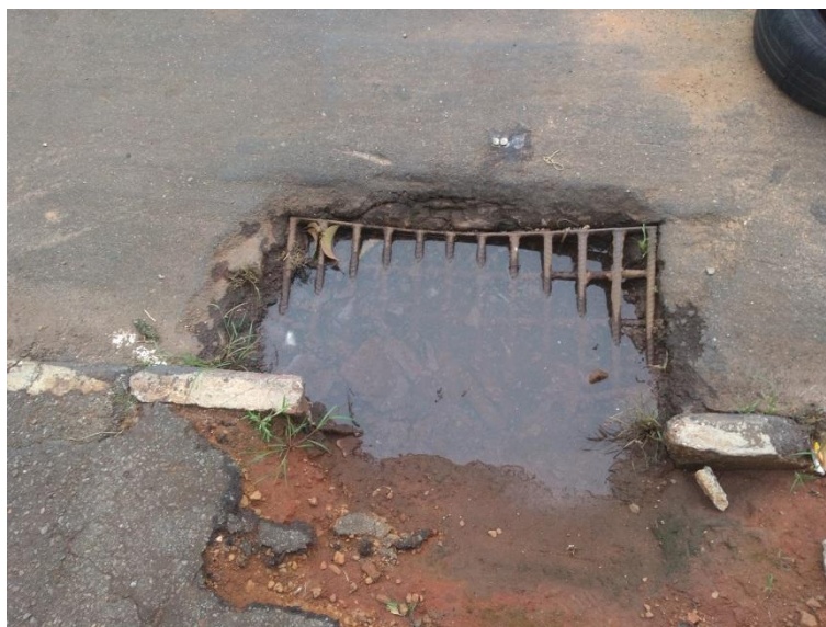
Figura - 26 - Boca de Lobo N.º 25.
