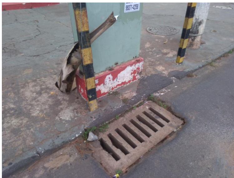
Figura - 37 - Boca de Lobo N.º 32.
