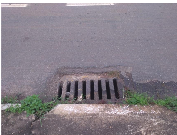
Figura - 16 - Boca de Lobo N.º 15.
