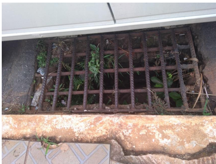
Figura - 27 - Boca de Lobo N.º 26.
