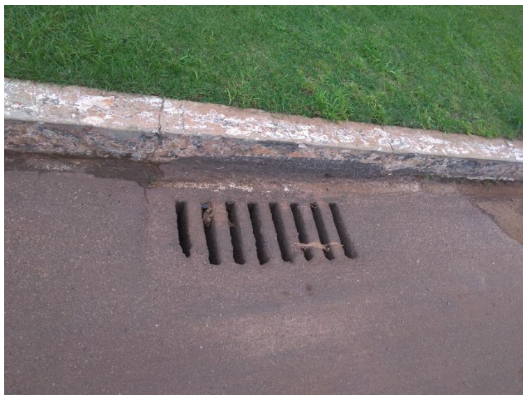
Figura - 21 - Boca de Lobo N.º 20.
