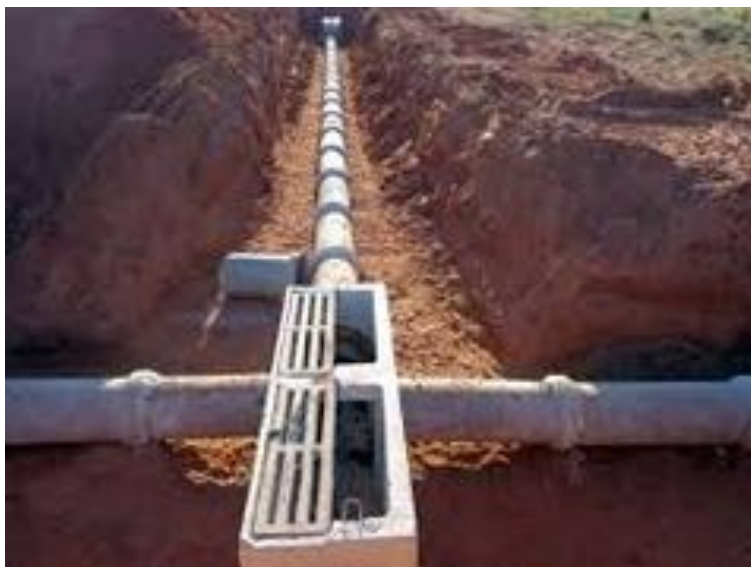
Figura 13 - Galeria de Águas Pluviais
