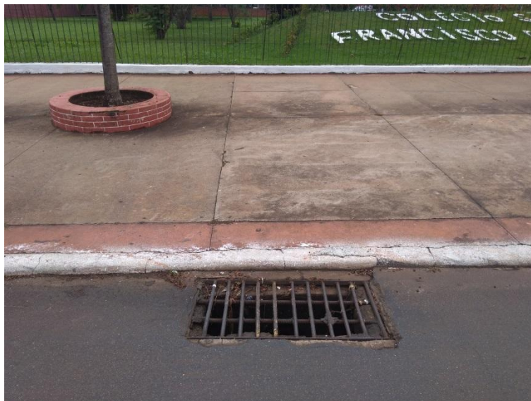
Figura - 8 - Boca de Lobo N.º 7.
