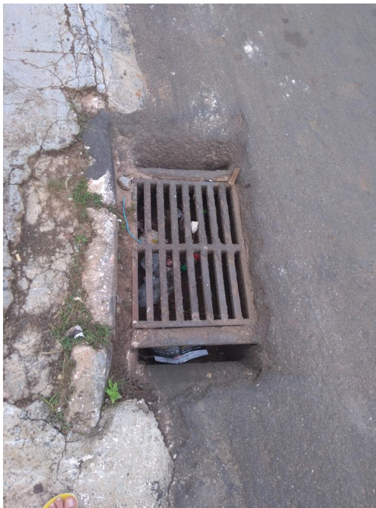
Figura - 33 - Boca de Lobo N.º 30.
