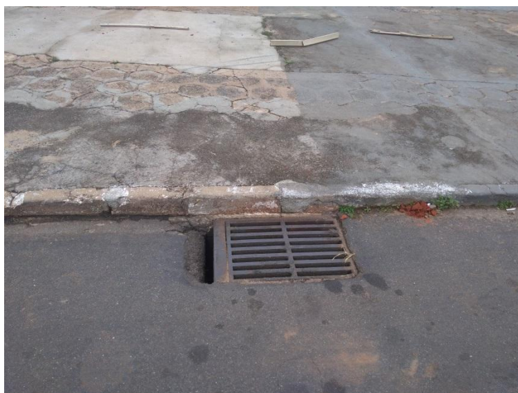
Figura - 35 - Boca de Lobo N.º 31.
