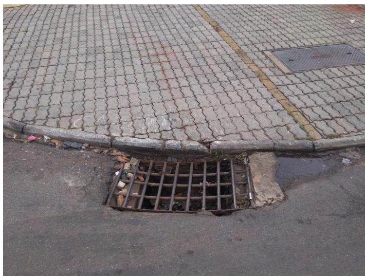
Figura - 3 - Boca de Lobo N.º 2.
