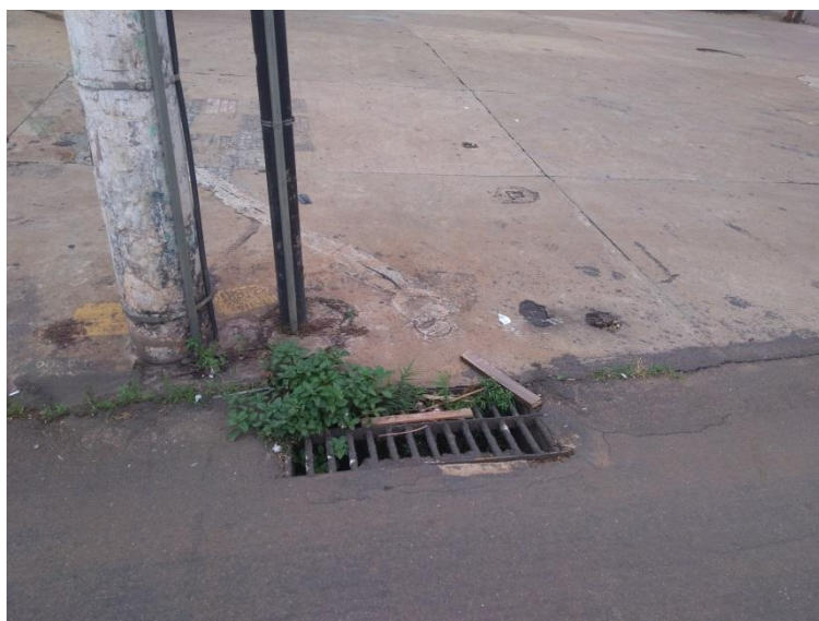
Figura - 29 - Boca de Lobo N.º 29.
