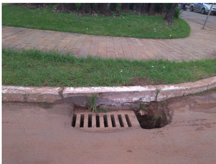
Figura - 22 - Boca de Lobo N.º 21.
