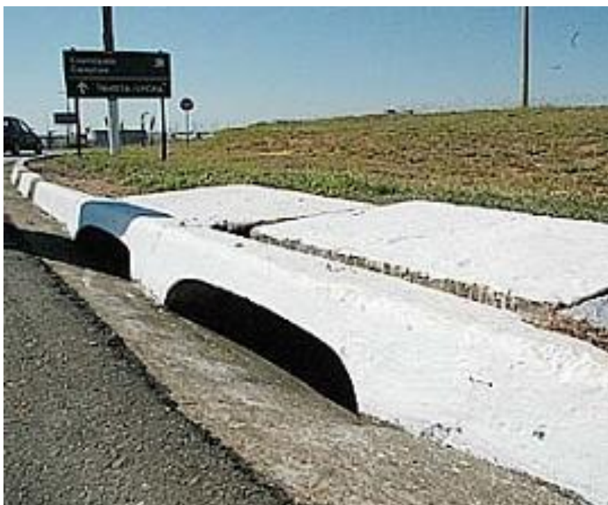
Figura 8 - Boca de Lobo de Meio Fio
