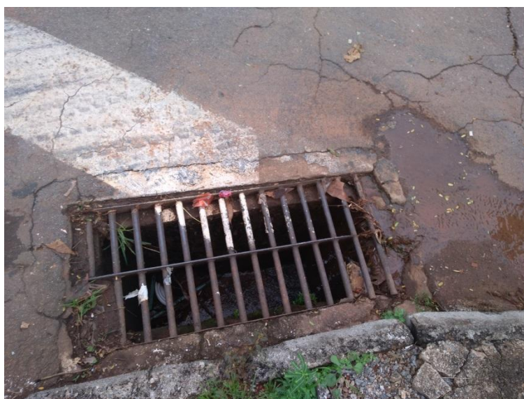
Figura - 10 - Boca de Lobo N.º 9.
