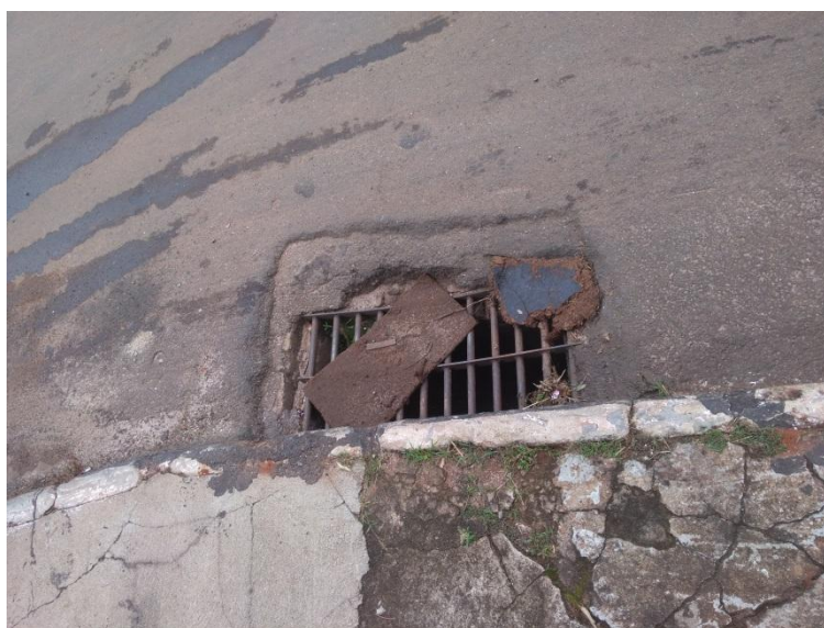
Figura - 24 - Boca de Lobo N.º 23.
