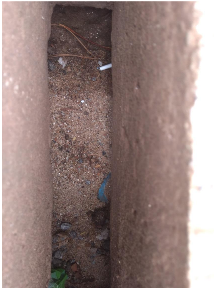
Figura - 38 - Detalhes do Interior da Boca de Lobo N.º 32.
