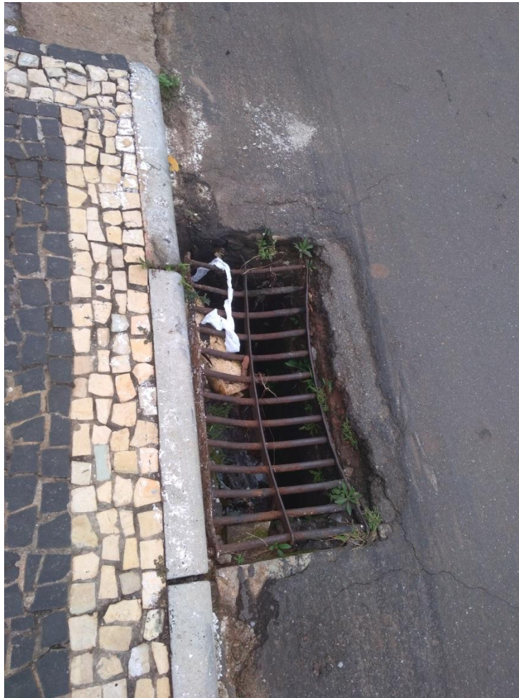
Figura - 11 - Boca de Lobo N.º 10.
