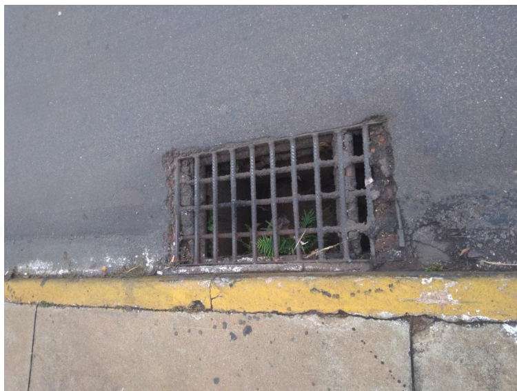
Figura - 31 - Boca de Lobo N.º 29.
