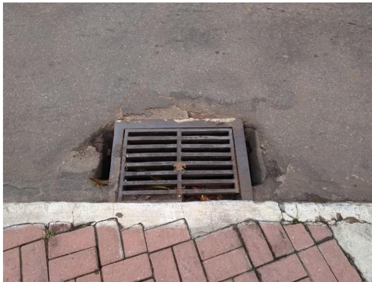
Figura - 2 - Boca de Lobo N.º 1.
