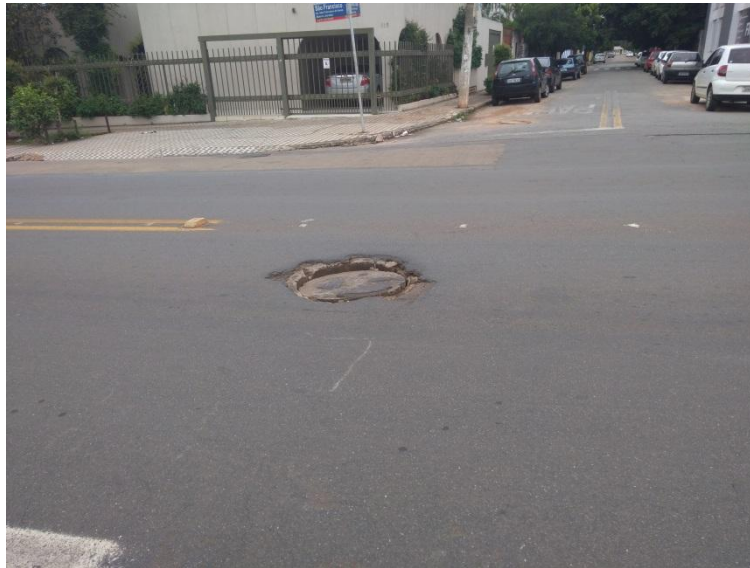
Figura - 36 - Poço de Visita N.º 2.
