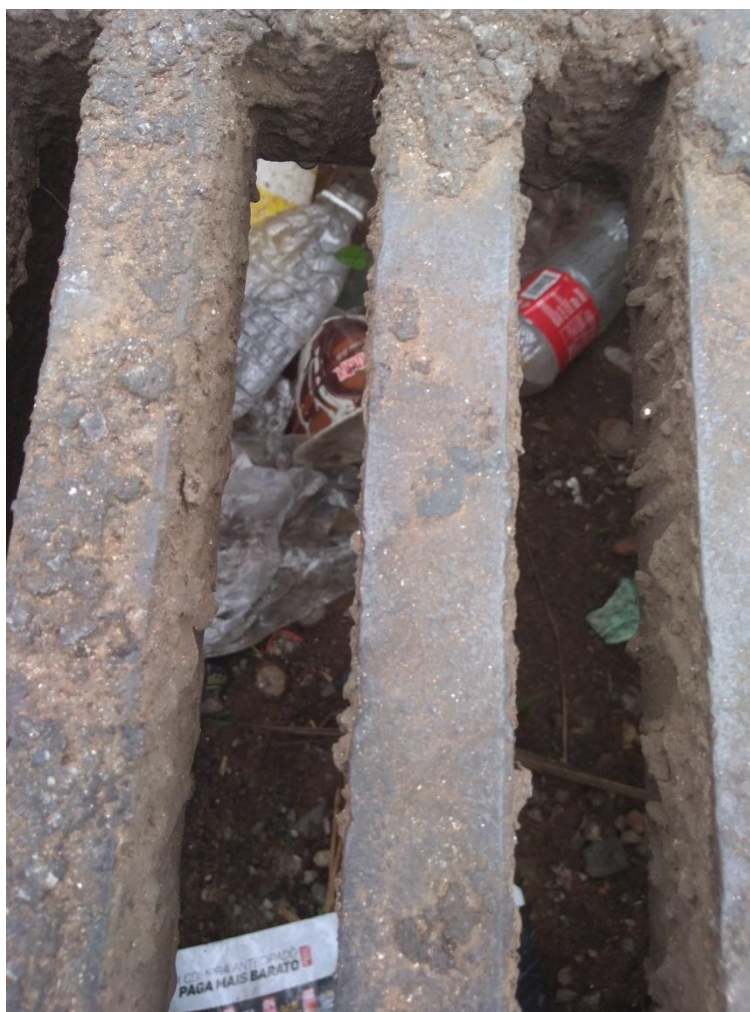
Figura - 34 - Detalhes do Interior da Boca de Lobo N.º 30.
