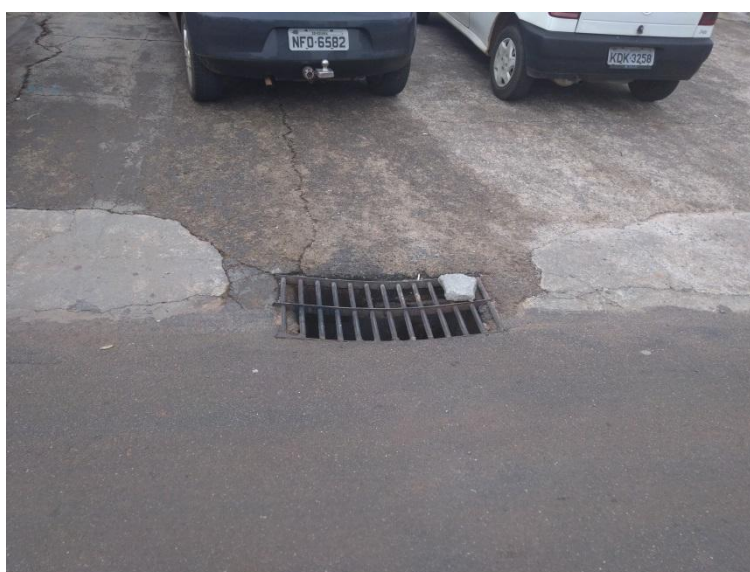
Figura - 18 - Boca de Lobo N.º 17.
