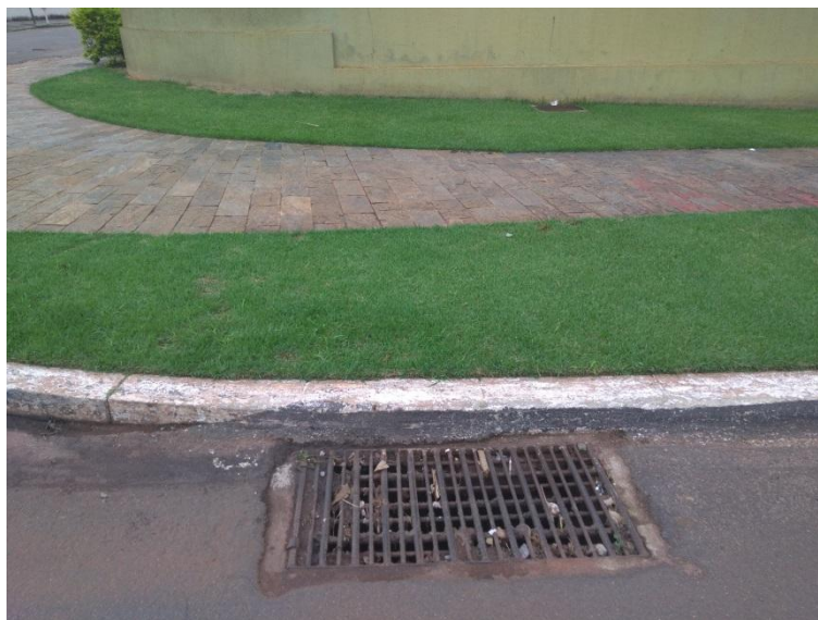
Figura - 20 - Boca de Lobo N.º 19
