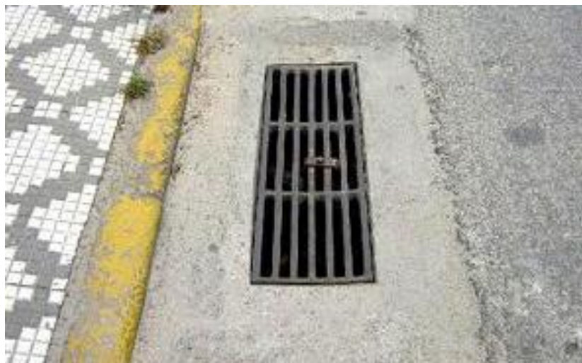
Figura 6 - Boca de Lobo Tipo Sarjeta
