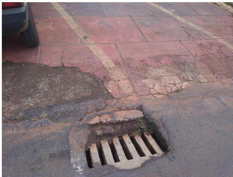
Figura - 12 - Boca de Lobo N.º 11.
