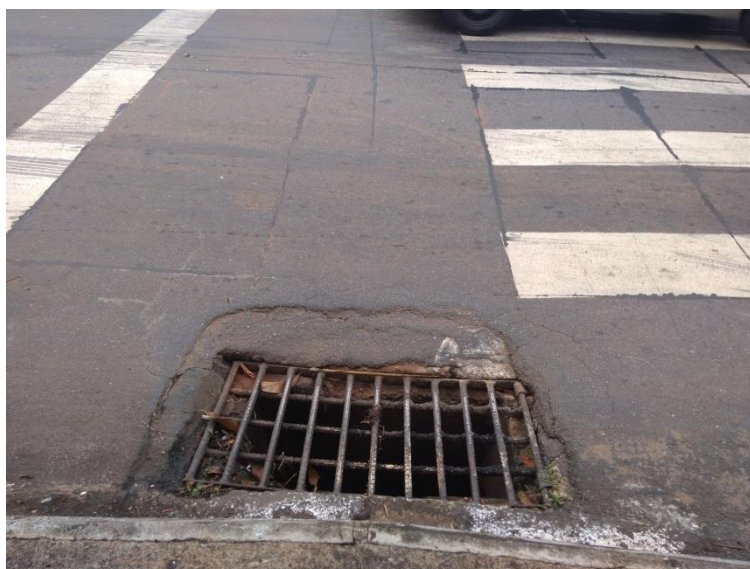
Figura - 9 - Boca de Lobo N.º 8.
