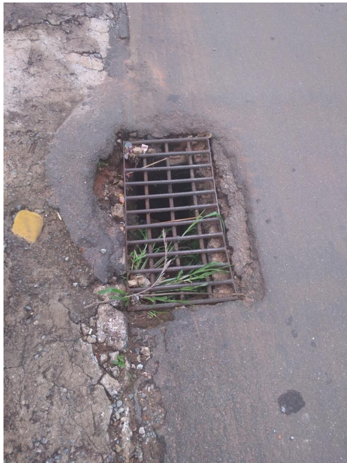
Figura - 14 - Boca de Lobo N.º 13.
