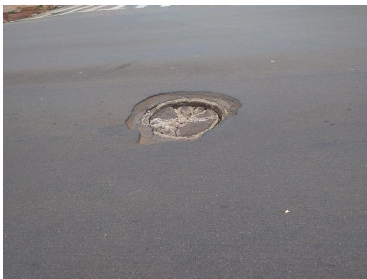
Figura - 32 - Poço de Visita N.º 1.
