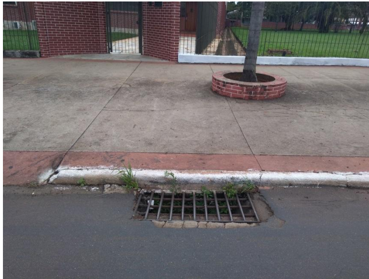
Figura - 7 - Boca de Lobo N.º 6.
