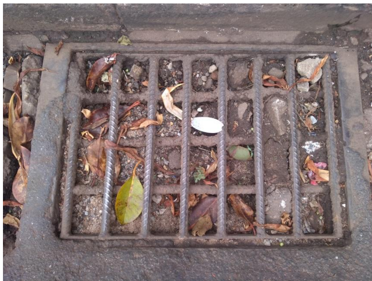
Figura - 39 - Boca de Lobo N.º 33.
