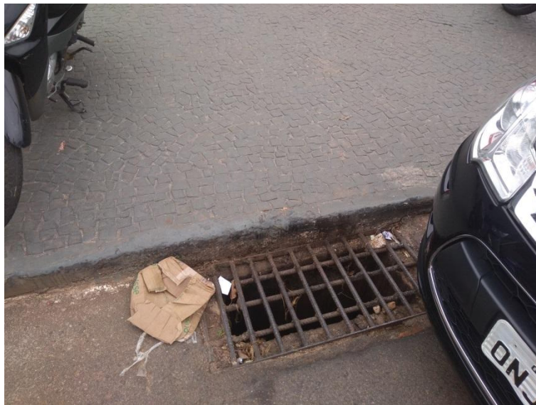
Figura - 25 - Boca de Lobo N.º 24.
