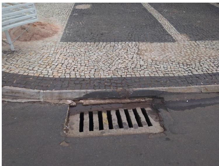
Figura - 4 - Boca de Lobo N.º 3.
