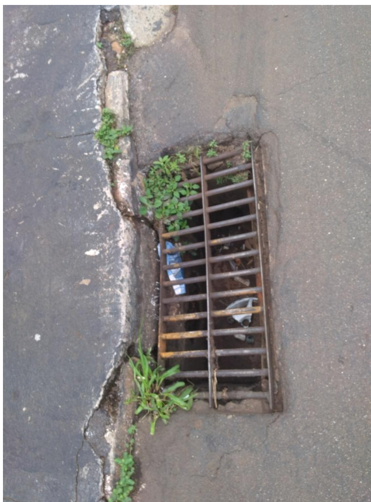
Figura - 30 - Boca de Lobo N.º 28.
