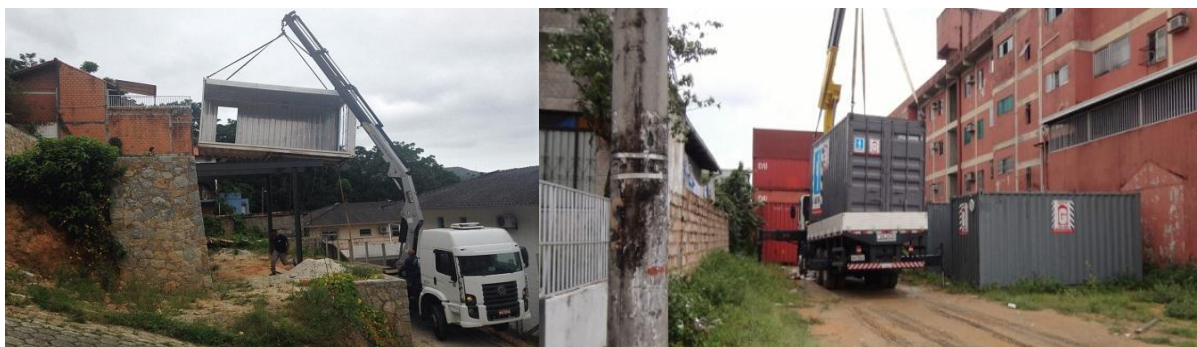
Figura 11: Descarga na obra
