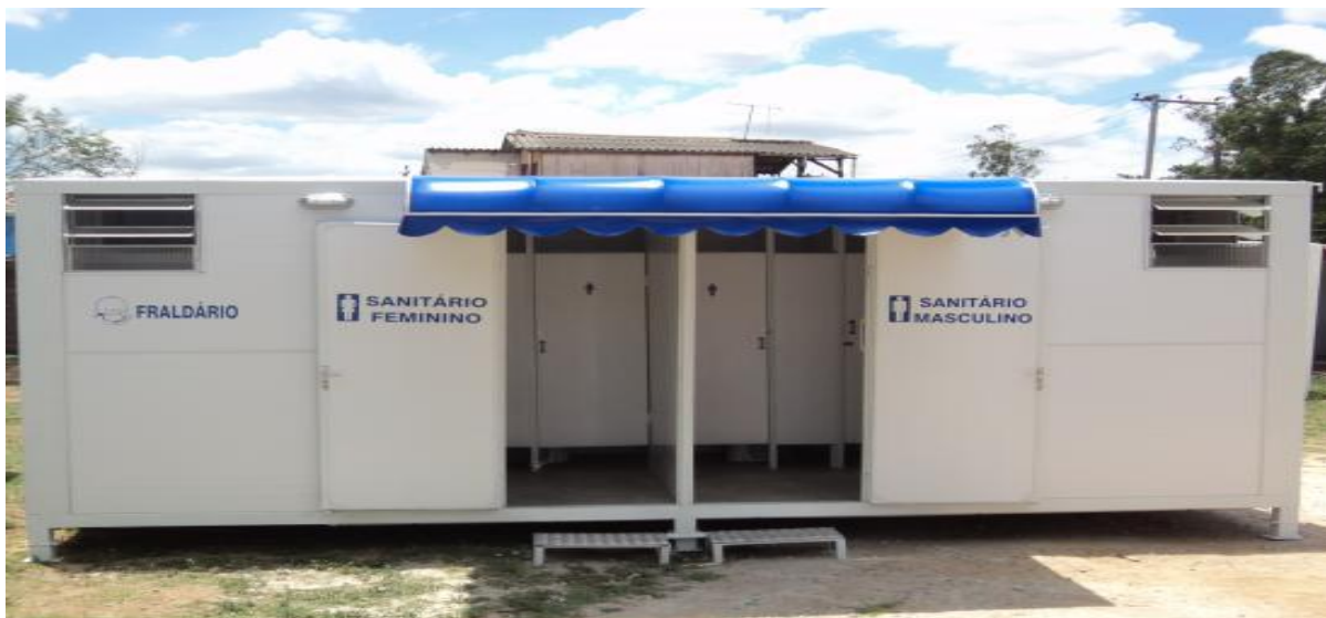
Figura 13: Banheiro para obra masculino e feminino
