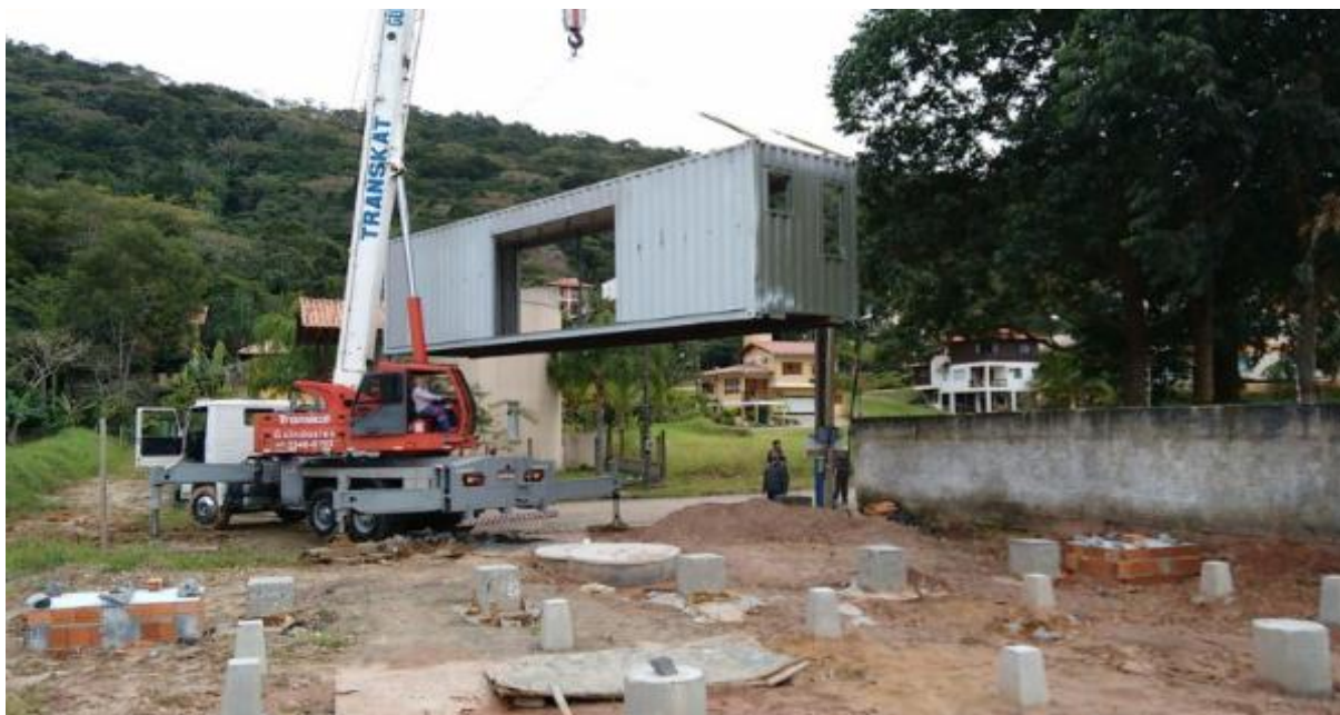
Figura 21: Ancoragem do contêiner nas sapatas
