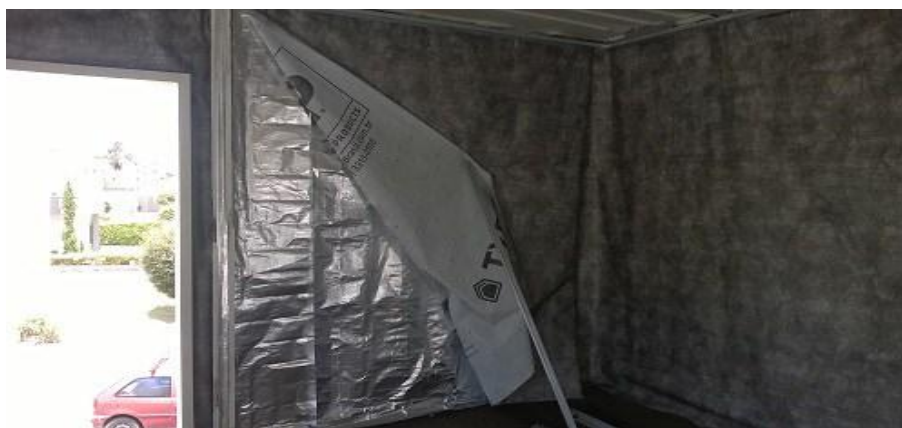
Figura 25: Isolante térmico sendo executado
