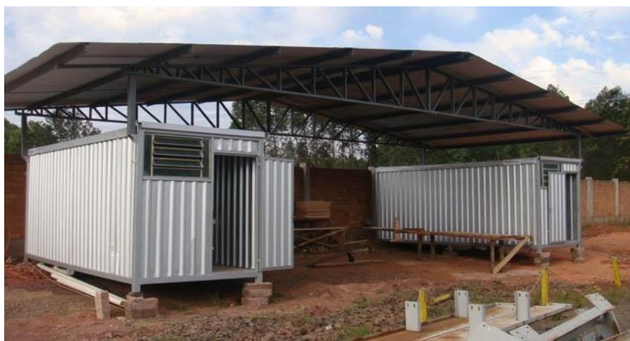
Figura 18: Estrutura metálica de galpão para telhado
