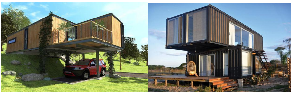
Figura 10: Terreno denivelado e balanço
