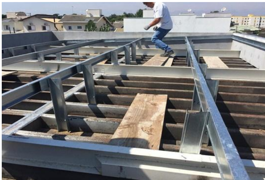
Figura 19: Estrutura do telhado
