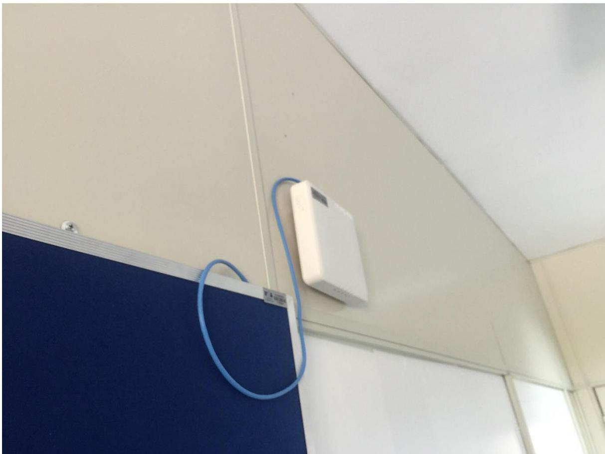
**Figura 46 –Equipamento ZoneFlex R600 Instalado**
