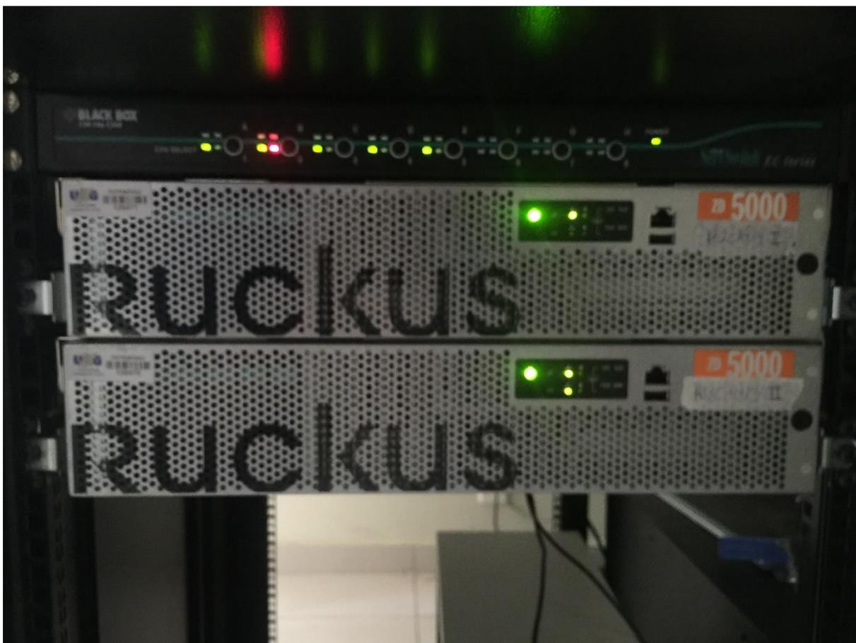
**Figura 45 –Equipamento ZoneDirector 5000 Instalado**
