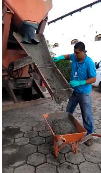
Figura 15 – Recebimento do concreto para ensaio do abatimento e moldagem
