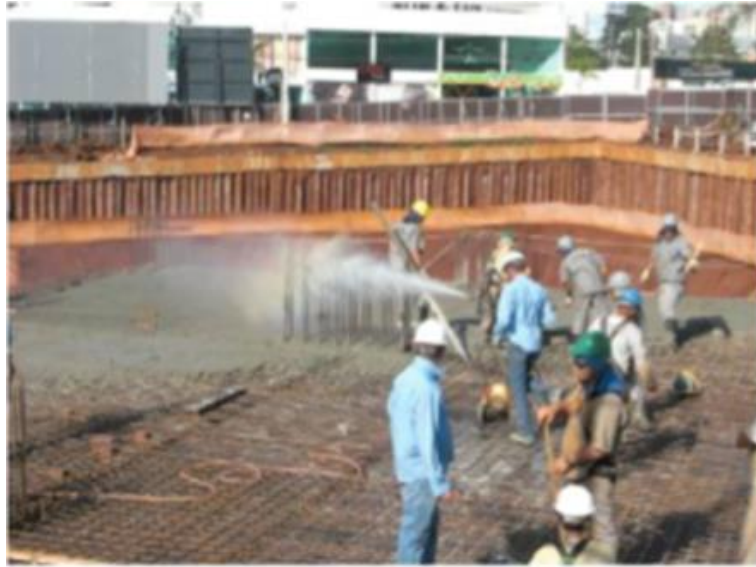
Figura 7 - Aspersão de água no concreto
