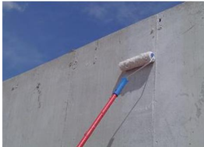
Figura 6 - Aplicação de líquido para cura úmida
